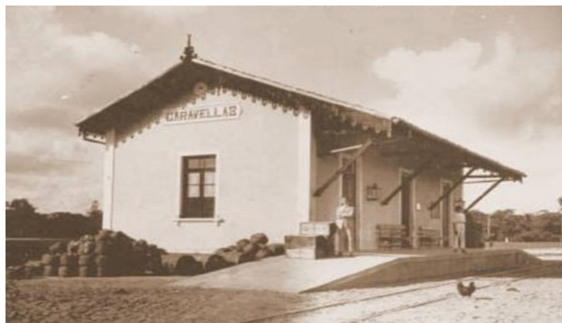
Figura 40: Estação de Caravelas
