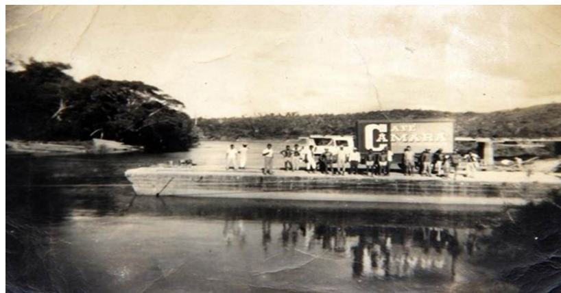
Figura 23: Entrada da Cascata e construção de uma ponte
