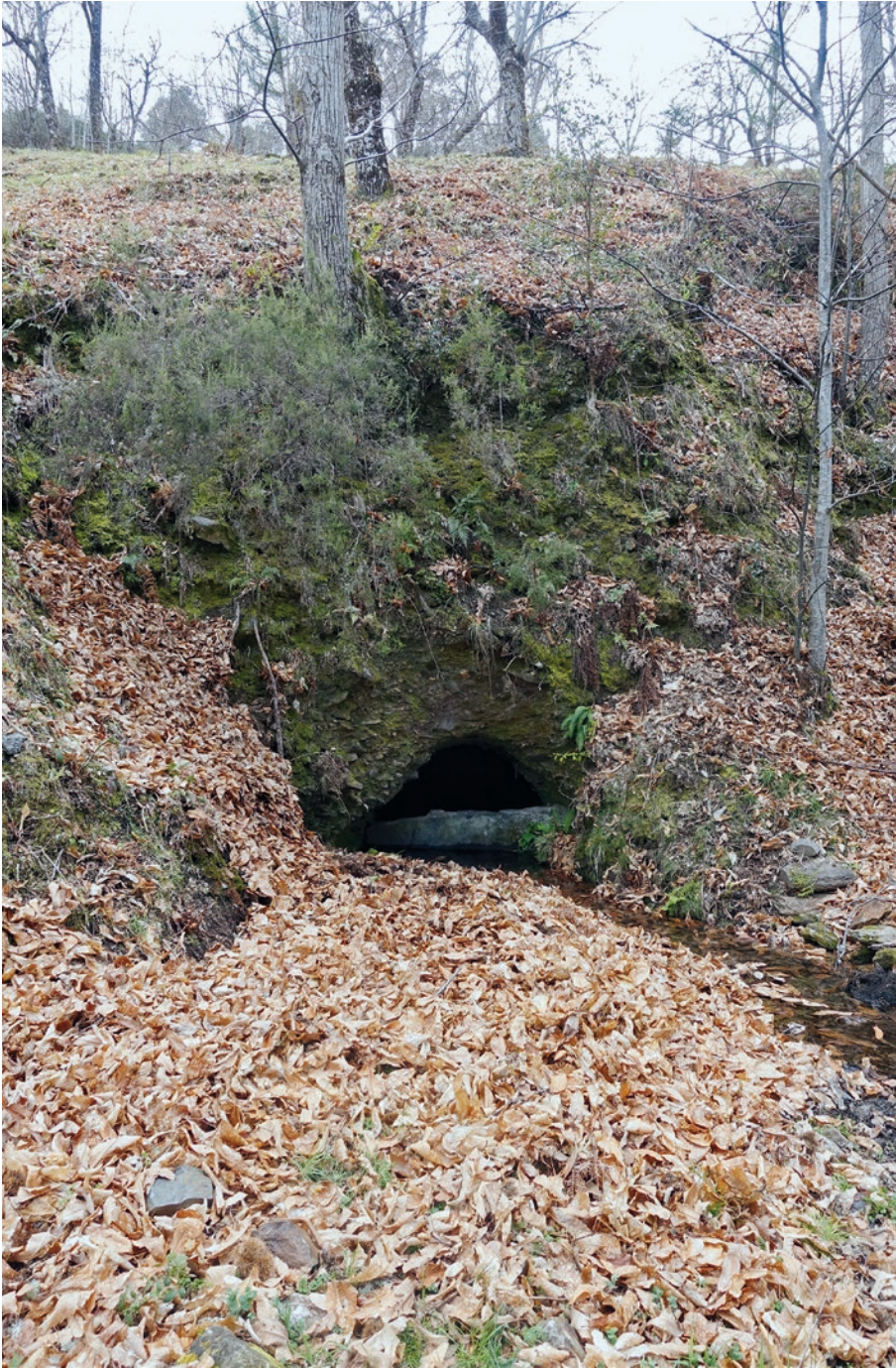
Fig. 3.3-25: Territorium metallorum Tresminas / Jales, Tresminas, Corta de Covas, Galeria do Texugo: tunnel port from the north (photo: R. Wahl-Clerici).
