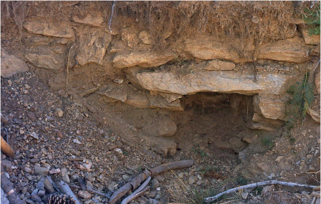
Fig. 5.0-38 Territorium metallorum Tresminas / Jales, Forno dos Mouros: drainage channel (photo: R. Wahl-Clerici).
