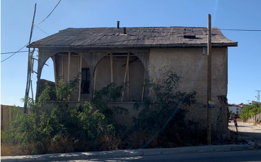
Resim 7. Doğu cephe fotoğrafı
