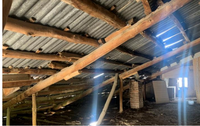
Resim 8. 2-03 mahalinden çekilen çatı fotoğrafı
