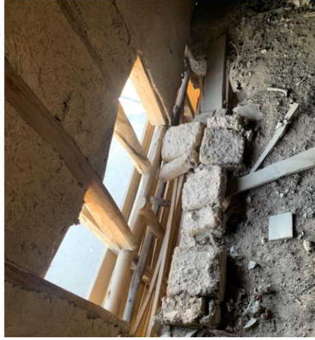
Resim 31. Ahşap çatki kerpiç dolgu duvar
