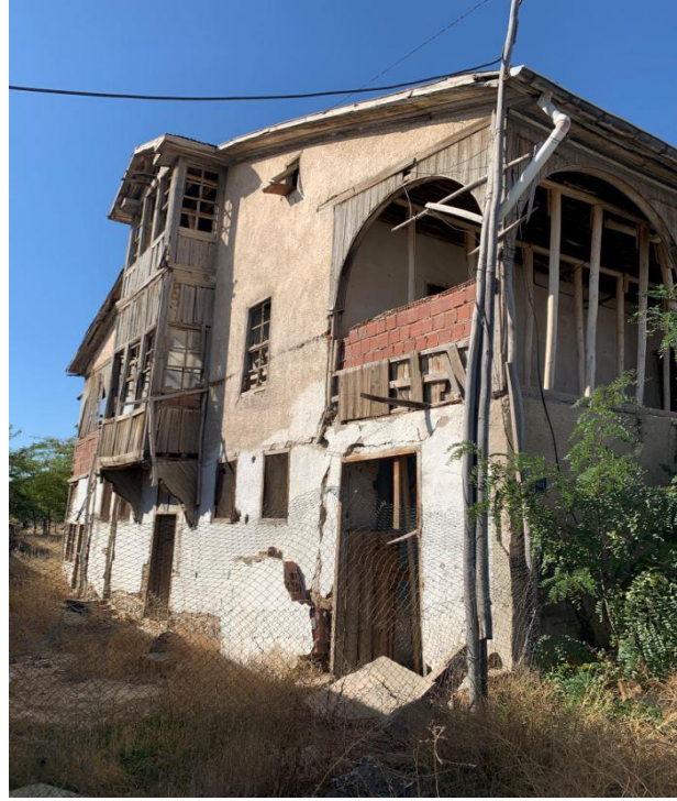
Resim 3. Güney cephe fotoğrafı
