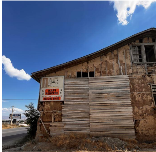
Resim 32. Kuzey cephedeki bozulmalar
