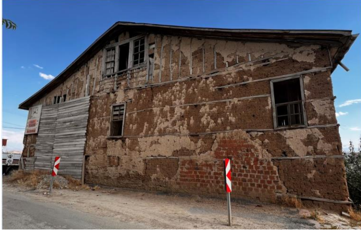
Resim 4. Kuzey cephe fotoğrafı
