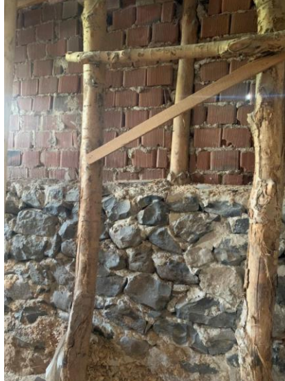
Resim 37. Z-01 mahalindeki yıkılan kerpiç duvar yerine örülen tuğla duvar.
