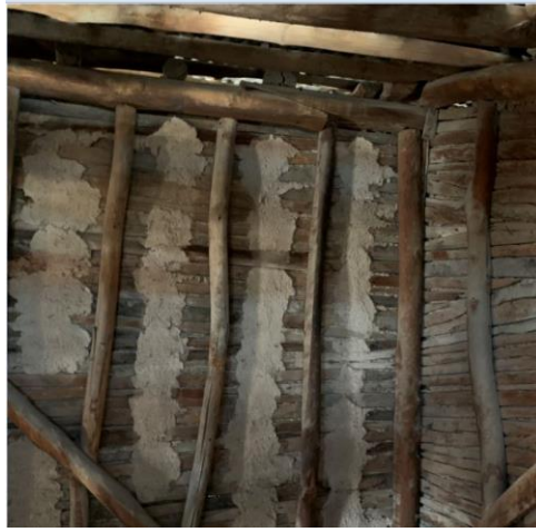
Resim 30. Çatı katındaki bağdadi duvar
