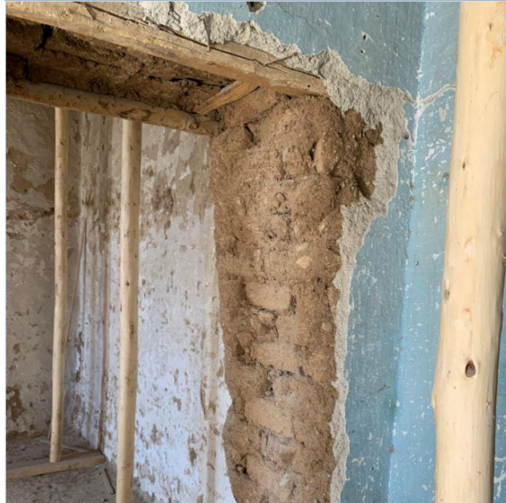
Resim 42. Z-07 mahaline geçiş için yıkılan duvar
