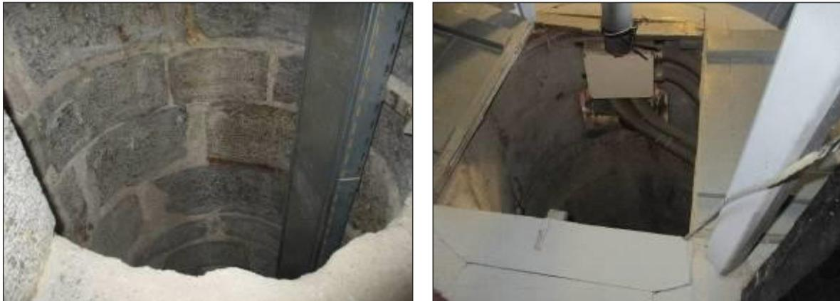
Figura 16. Fotografías del hueco/canalón para el descenso de pesas en la Cámara de Servicio del Faro del Cabo de Palos en la actualidad (Fotografías de Santiago Sánchez Beitia).
