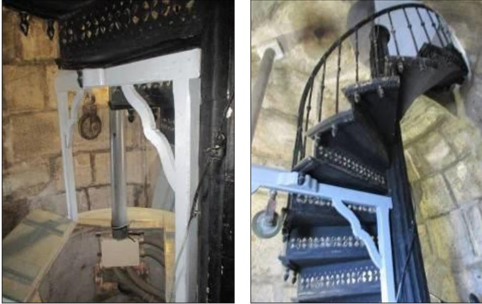
Figura 15. Fotografías del pescante para el descenso de pesas en la Cámara de Servicio del Faro del Cabo de Palos en la actualidad (Fotografías de Santiago Sánchez Beitia).
