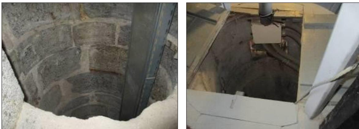
Figura 16. Fotografías del hueco/canalón para el descenso de pesas en la Cámara de Servicio del Faro del Cabo de Palos en la actualidad (Fotografías de Santiago Sánchez Beitia).
