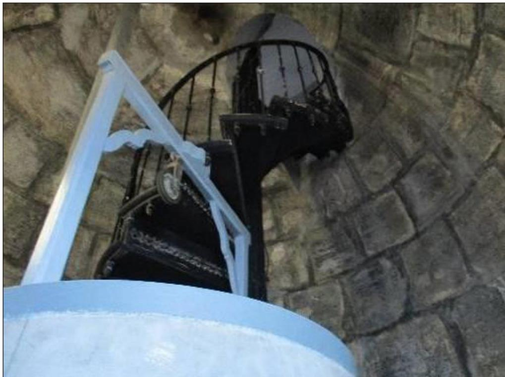
Figura 13. Fotografía de la escalera de fundición conectando la Cámara de Servicio con la Linterna del Faro del Cabo de Palos en la actualidad (Fotografía de Santiago Sánchez Beitia). Se aprecia el remate superior de la torre y el acceso lateral a la Linterna.
