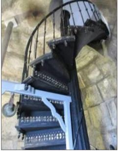
Figura 15. Fotografías del pescante para el descenso de pesas en la Cámara de Servicio del Faro del Cabo de Palos en la actualidad (Fotografías de Santiago Sánchez Beitia).
