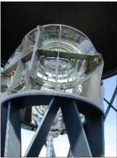
Figura 14. Fotografías de la óptica ubicada en la Linterna de la torre del Faro del Cabo de Palos en la actualidad (Fotografías de Santiago Sánchez Beitia).
