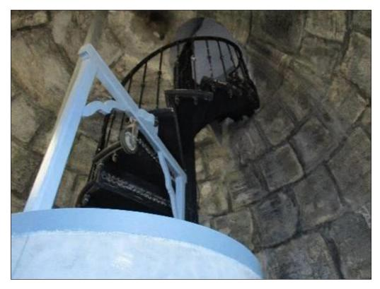
Figura 13. Fotografía de la escalera de fundición conectando la Cámara de Servicio con la Linterna del Faro del Cabo de Palos en la actualidad (Fotografía de Santiago Sánchez Beitia). Se aprecia el remate superior de la torre y el acceso lateral a la Linterna.
