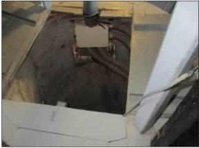
Figura 16. Fotografías del hueco/canalón para el descenso de pesas en la Cámara de Servicio del Faro del Cabo de Palos en la actualidad (Fotografías de Santiago Sánchez Beitia).
