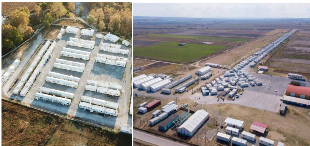
Εικόνα 10 και Εικόνα 11: «Δομή Φιλοξενίας στη Κάτω Μηλιά Πιερίας και στη Νέα Καβάλα Πολύκαστρου» (πηγή: Υπουργείο Μεταναστευτικής Πολιτικής, 2018)
