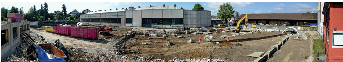
41 Brugg-Kabelwerke 2007–2008 (Bru.007.3). Panoramafotografie des Areal des Sakralbaus der Zivilsiedlung West.
