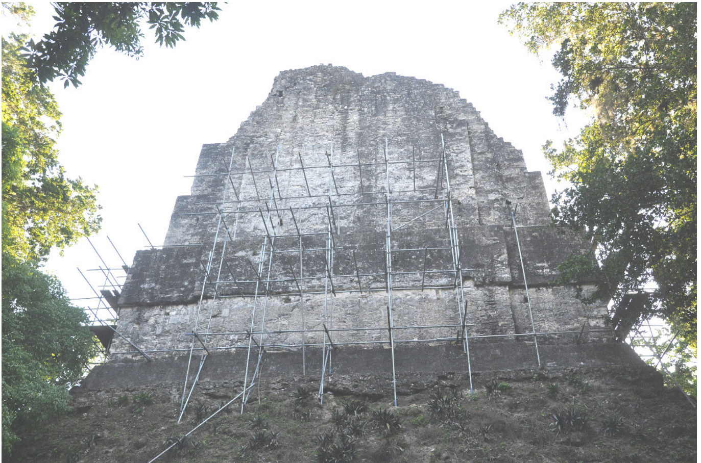
Figura 4. Los andamios en la fachada este del Templo VI.
