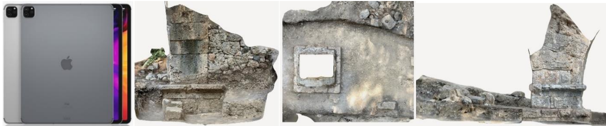
Şekil 7. 12.9 inç iPad Pro tablet ile Phaselis Antik Kenti su kemerlerinde yapılan LİDAR taramaları.
