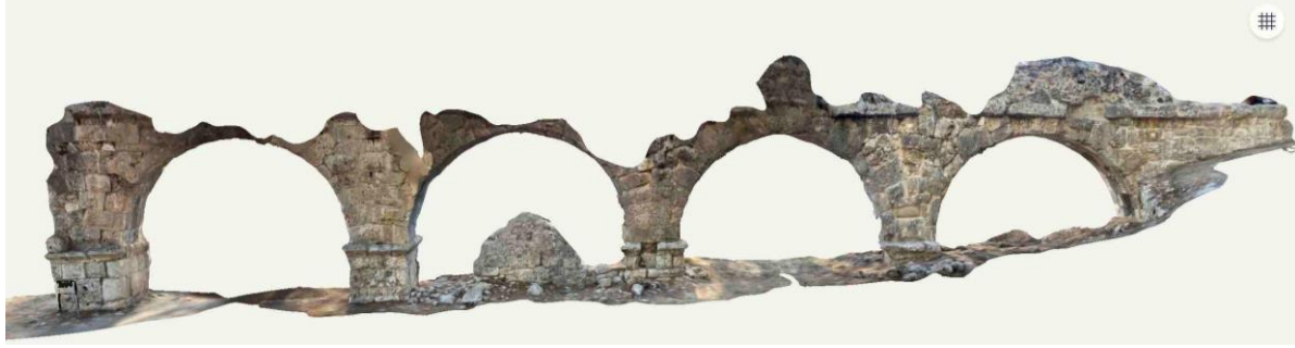
Şekil 8. LİDAR tarama ile elde edilen A1- A5 kemer ayakları, doğu cephesi.
