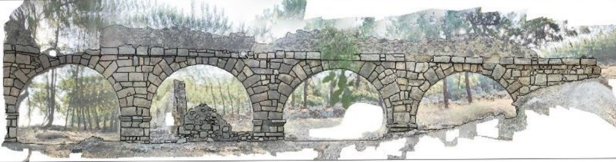
Şekil 3. Fotogrametri yöntemi ile elde edilen Phaselis Su Kemerinin doğu cephesinin A1-A5 kemer ayakları arası 3 boyutlu modeli ve rölöve çizimi.
