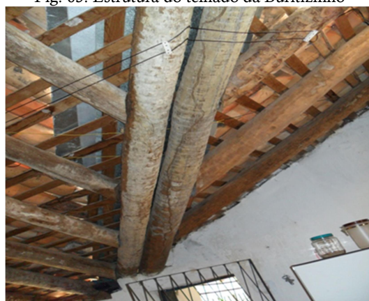
Fig. 03: Estrutura do telhado da Buritizinho
