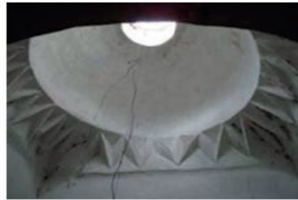
Yeşil Hamam, Bursa, 1481
