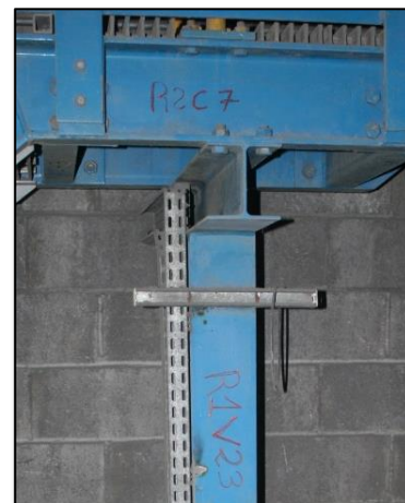
Figura 8: Exemplo do sistema de codificação de estruturas
