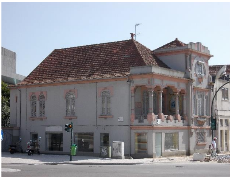
Figura 1: Estado atual do edifício: fachada principal
