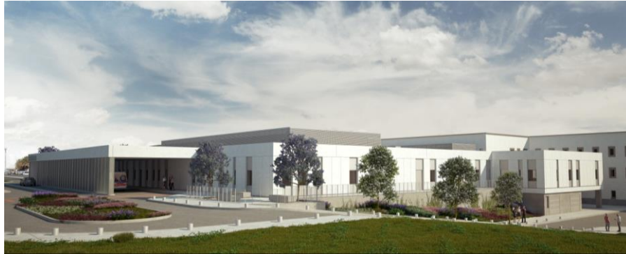
Figura 2: HP-HDES Urgência – Visão Geral do acesso Principal do Recinto Hospitalar com o edifício existente.
