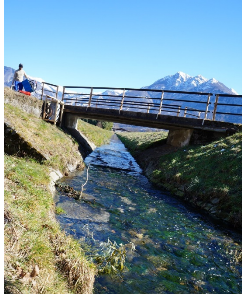
Canale Piano di Magadino (9.0 km 2 , SO: 4)
