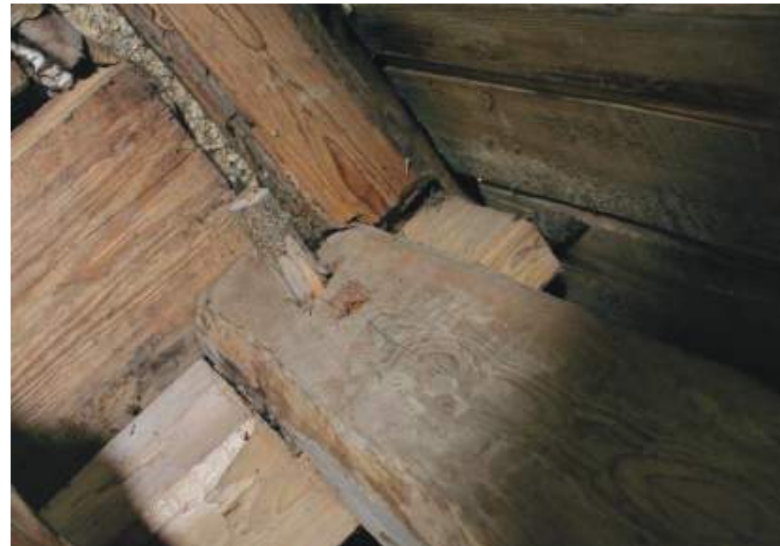
Harjaliitos on yksinkertainen lapaliitos, joka on kiinnitetty pitkällä puutapilla. Harjan päällä kulkee ylin naulauspuu, johon on tehty loveukset selkäpuiden päitä varten. Kuvassa erottuu puutapin alapuolella väärään kohtaan tehty ensimmäinen reikä.
