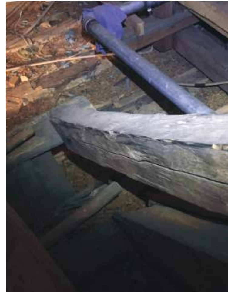
Hollantilainen tukeutuu alapäästä järeeän lankkuun, joka lepää räystääskonsolin päällä.
