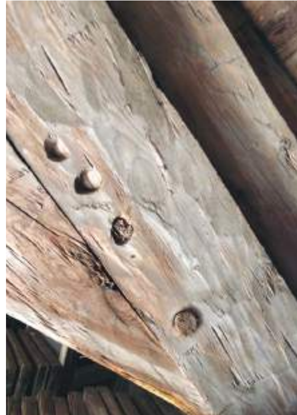
Uloimmassa pukissa MF (I) näkyy pönkän liitoksen yläpuolella kaksi kuoppaa. Kuopat saattavat olla porausta varten veistettyjä alkukuoppia, jotka ovatkin osuneet väärään kohtaan.
