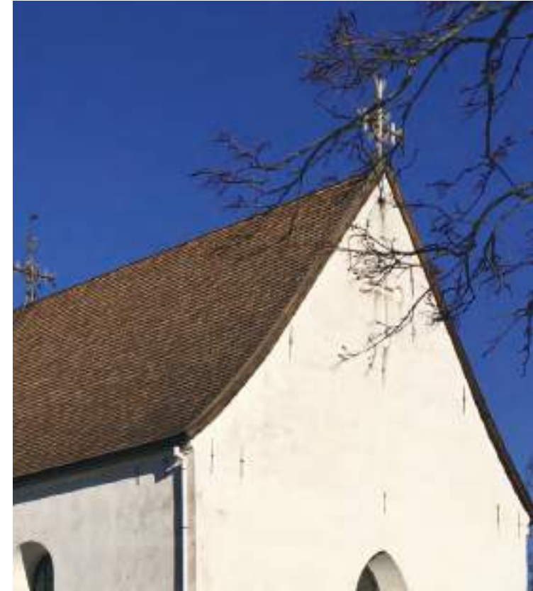
Alapaarteet on sidottu tiilimuriin julkisivussa näkyvin ankkuriraudoin. Myös uloimman kattotuolin ankkuriraudat näkyvät päätymuurissa.
