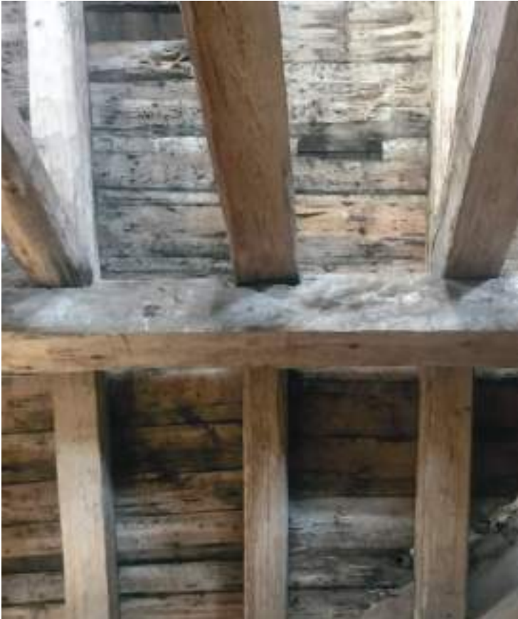
Uloimpia vuoliaisia on tarvittaessa veistetty kitapuiden alta.
