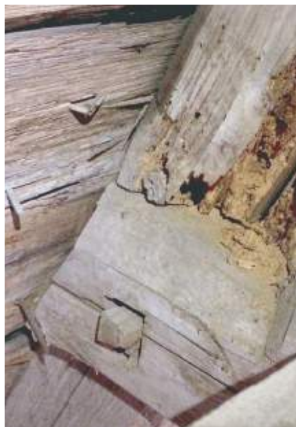
Kattotuolissa tapinreiän porausta varten tehty alku on nelikulmainen.
