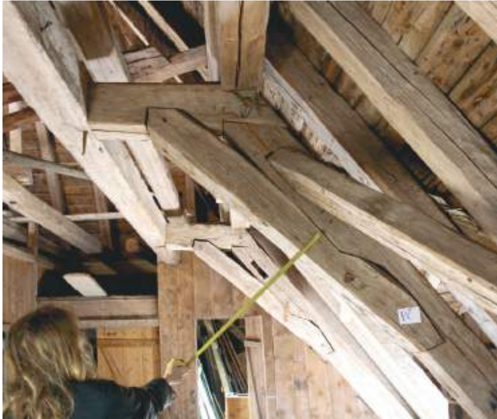
Päätypukki PC. Taustalla näkyy ullakon komero, jossa on tutkimuksen kohteena oleva päätypukki PA.
