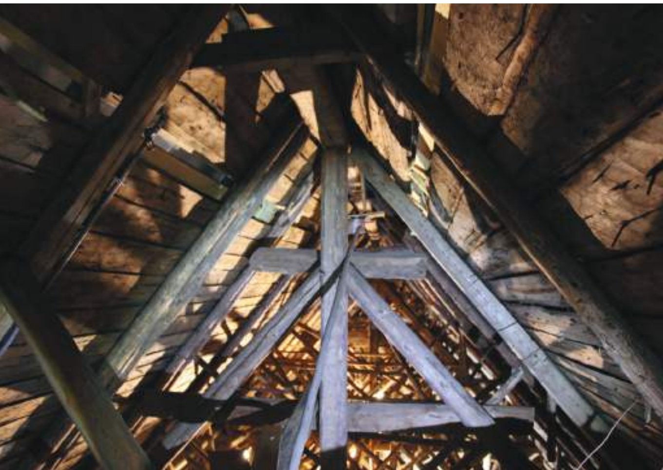
Näkymä katon harjalta. Selkäpuut tukeutuvat kurkihirteen, jota kannattelee ansaan riipputanko ja sen välityksellä ansaan nyteet.
