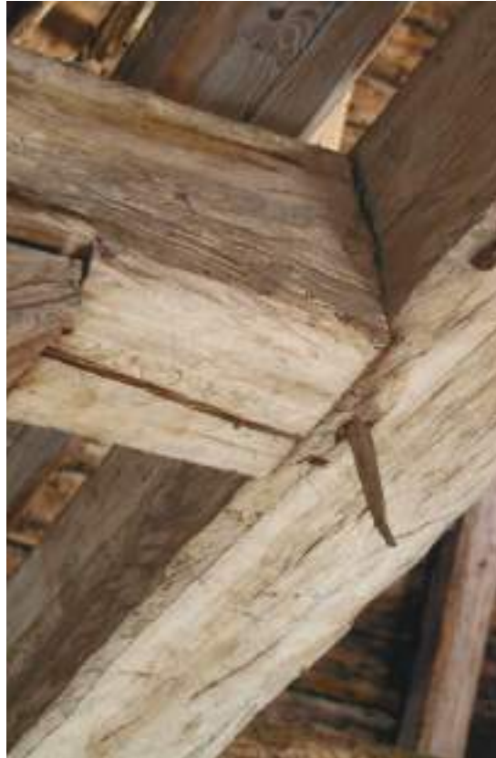
Päätypukin liittyminen uloimman pukin niskaan. Pukkien liitokset on veistetty huomattavan tarkasti: rakenteessa ei näy vääntyneitä eikä auenneita liitoksia.
