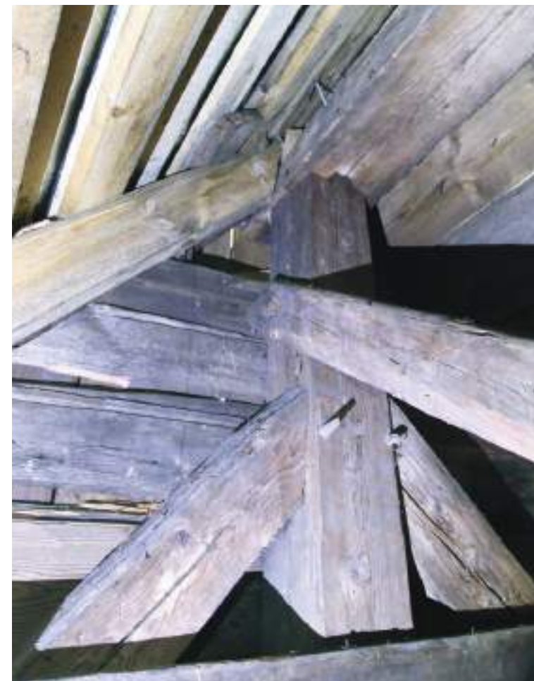
Nyteet on kiinnitetty riipputankoon lovitappiliitoksella. Riipputangon ja kurkihirren liitos on myös loviliitos.
