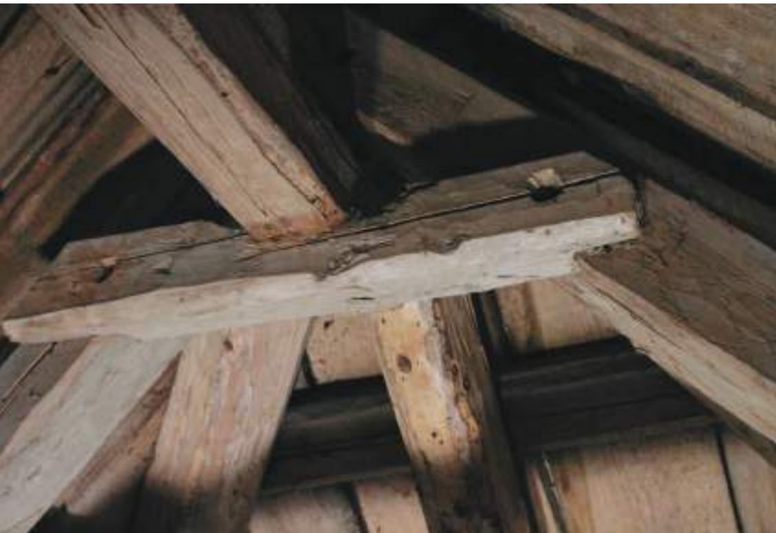
Ylin vaakatuki a on kiinnitetty naulaamalla selkäpuihin ja sen päällä kulkee vaakasuuntainen hirsi. Tukipuiden a päällä lepäävää hirttä on mahdollisesti käytetty rakennusvaiheessa nostamisessa.
