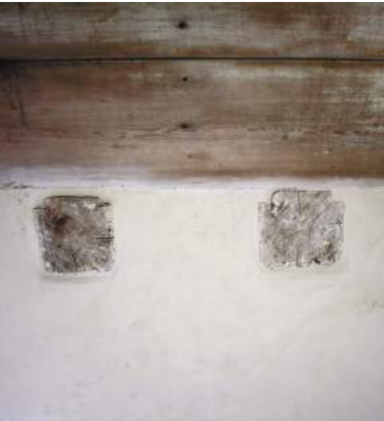
Tiilimuurin reunaa vasten katkaistut alapaarteet näkyvät porrashuoneen seinässä.
