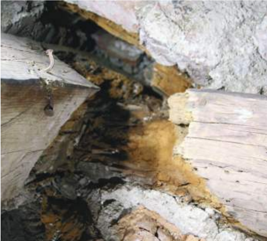
Näkymä päädyn rakenneavaukseen.
