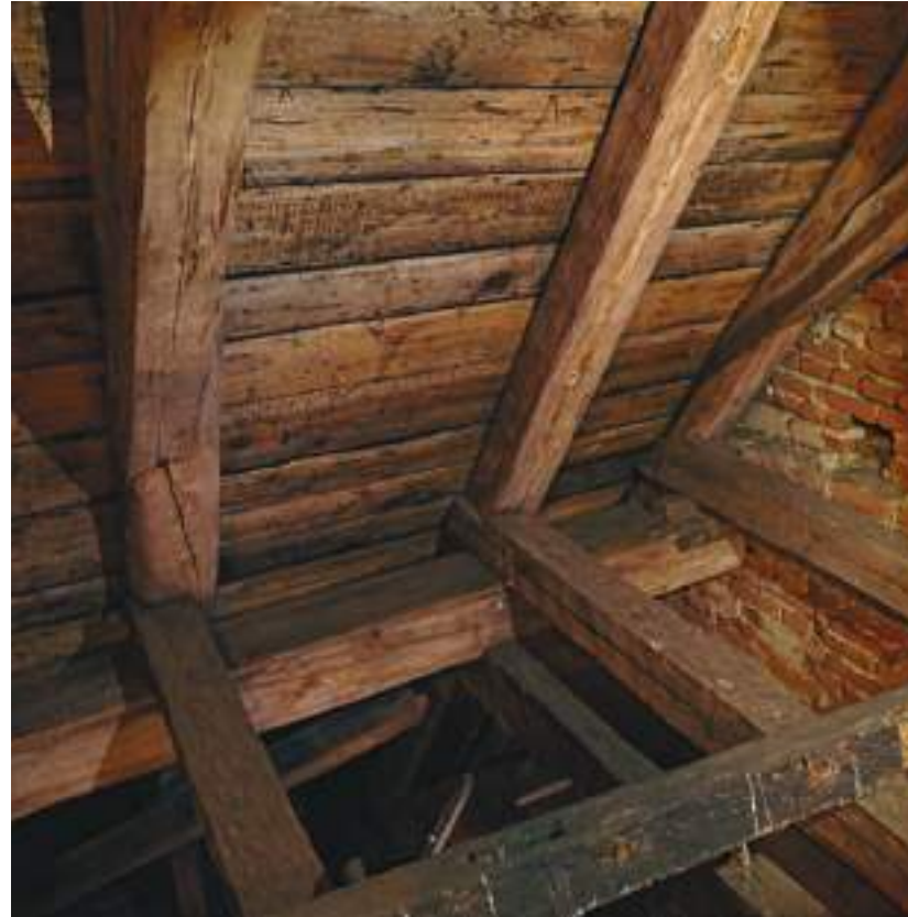
Joka neljännen kattotuolin kohdalla on pukkirakenne. Rakennuksen päissä uloimman pukkirakenteen ulkopuolella on vielä yksi kattotuoli. Uloin kattotuoli on kiinnitetty päätymuuriin ankkuriraudoin.
