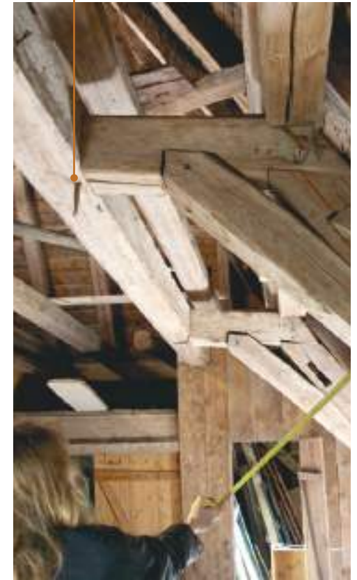
Päätypukin käpälän liitosten arveltiin olevan samanlaisia kuin päätypukin yläosan niskapuun liitokset.
