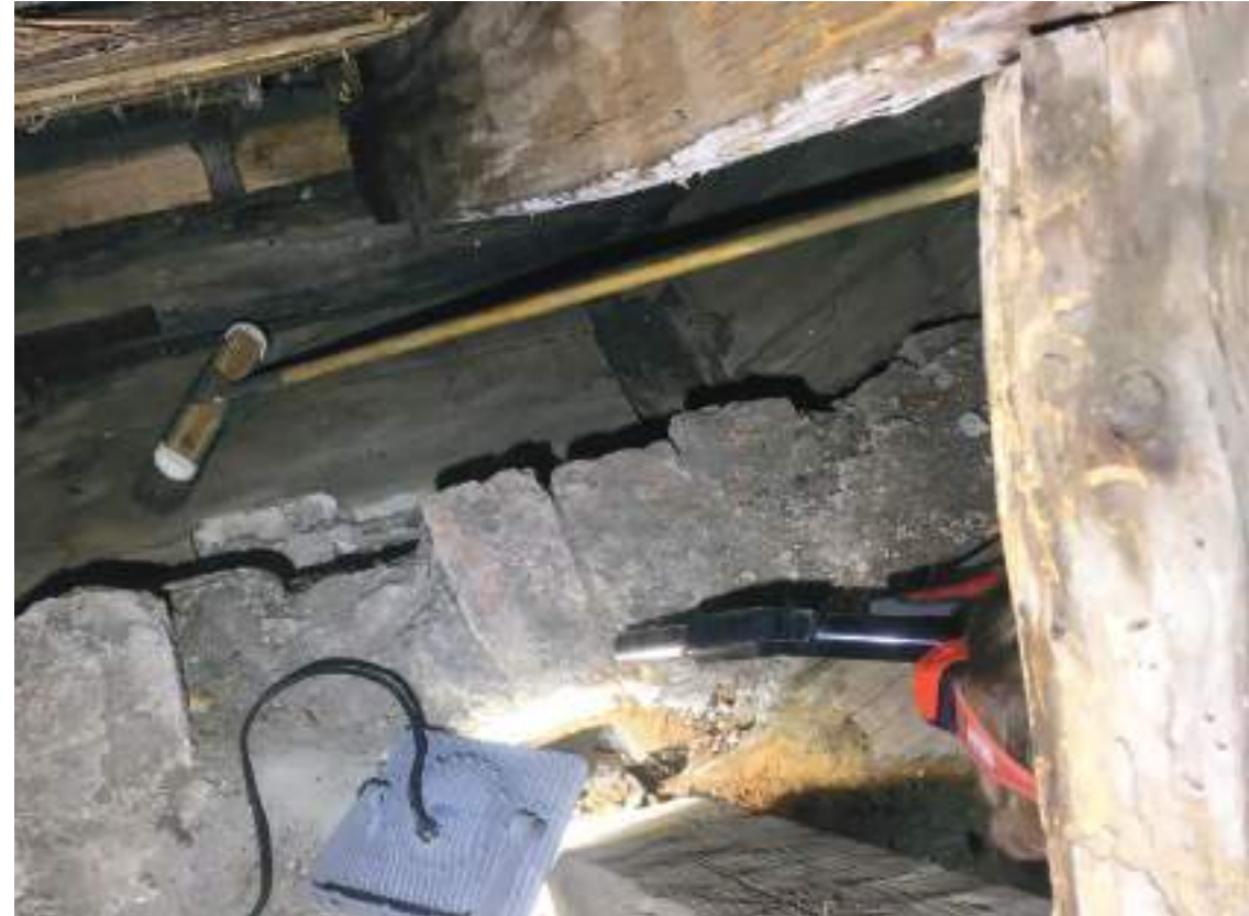
Päädyn rakenneavaus, muuri ja räystääs ylhäältä katsottuna.
