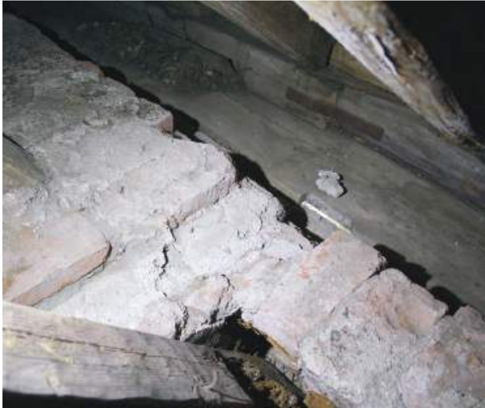
Räystäslautojen raosta näkyy konsolipalkki.
