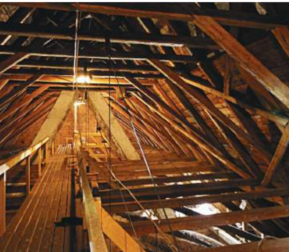
Näkymä alempien kitapuiden päältä. Kattotuolirakennetta on jäykistetty diagonaalein.
