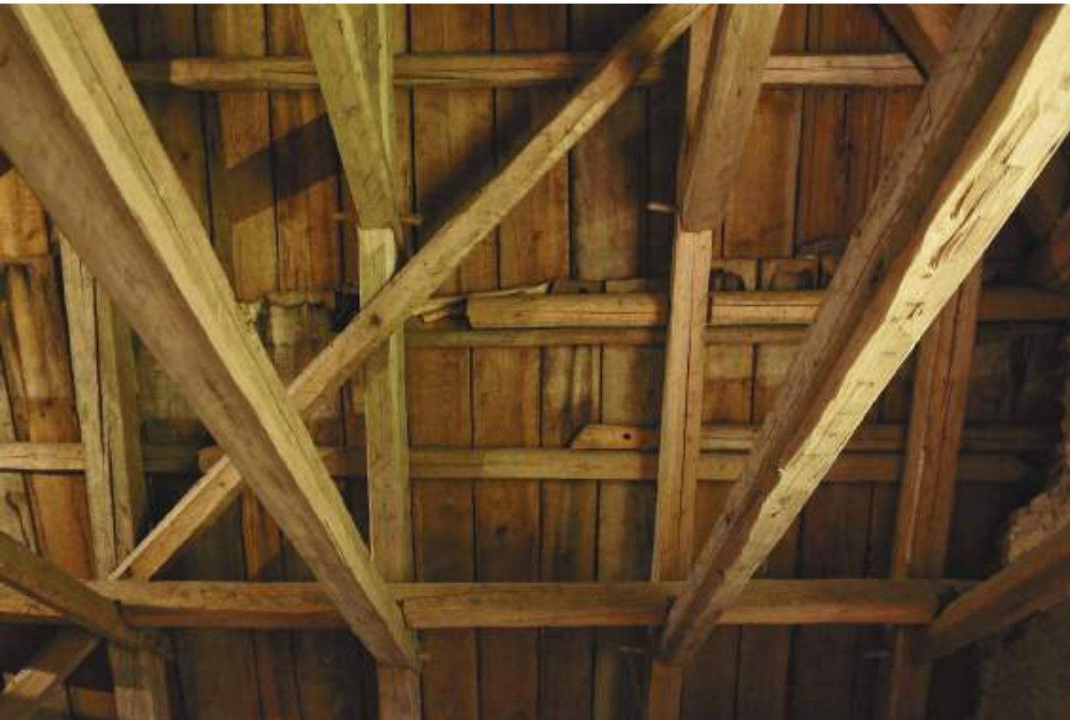
Naulauspuina on käytetty kierrätystavaraa. Myös katelautojen harmaantuneet päät kertovat menneistä, rakennusmateriaalia säästävistä korjaustoimista.
