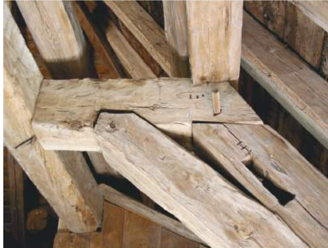
Päätypukki PC:n liitos pukkiin F (vanha numerointi I).
