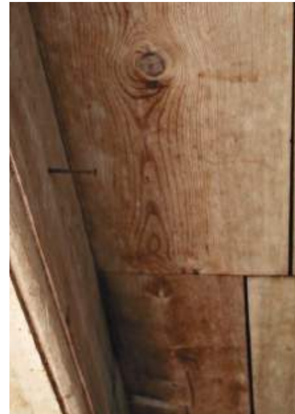
Yläpohjan maalaamatonta laipiolaudoitusta portaan varastossa.
