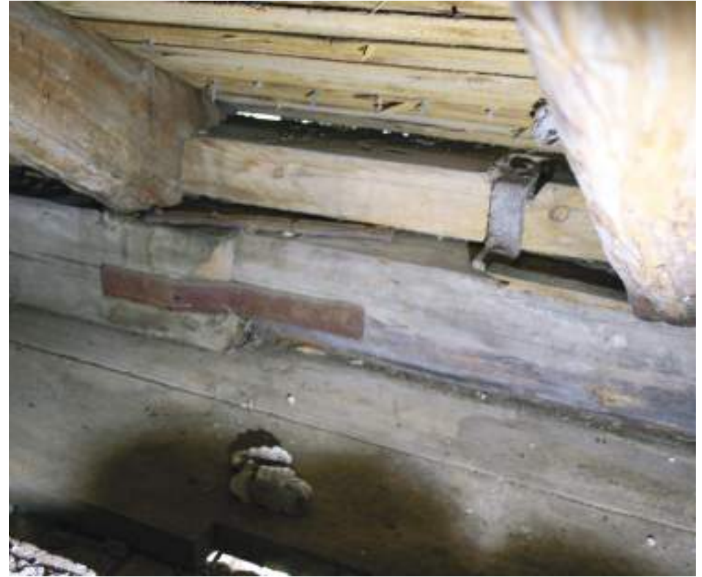
Räystäskonsolin päällä lepäävät räystäslaudat. Räystäshirsiä ja koururäystäspuita on sidottu yhteen metallisin kiinnikkein.
