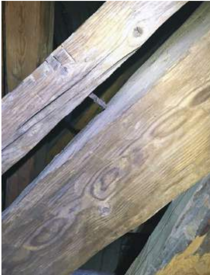
Hollantilainen on kiinnitetty selkäpuuhun naulaamalla.
