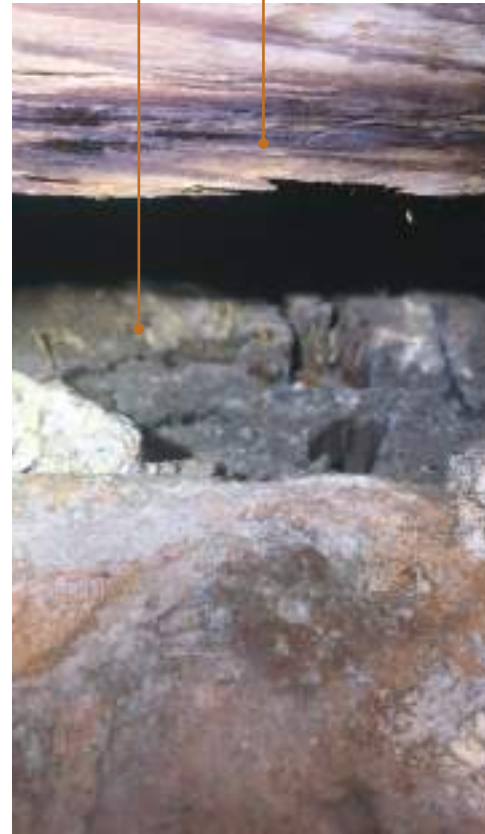
Kuvassa näkyy muurin sisään kätkeytyvä käpälä.
