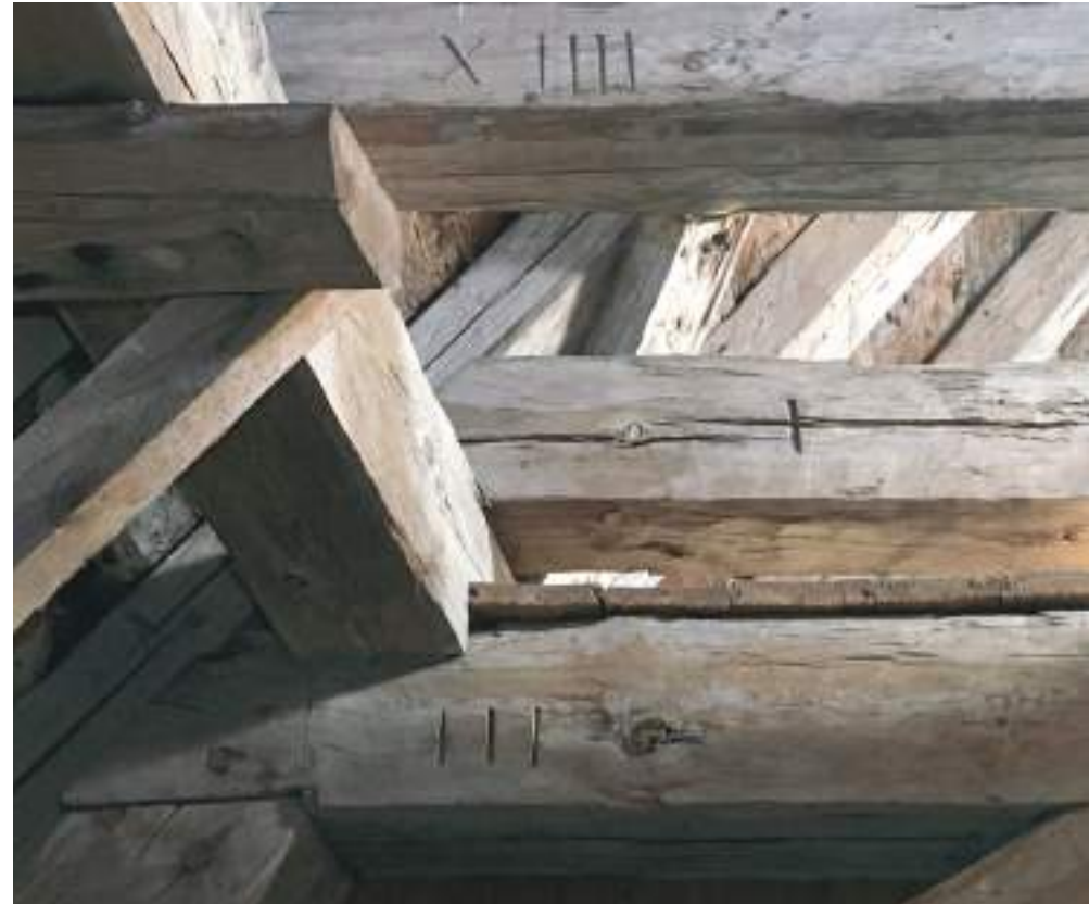
Kattorakenteen liitosmerkkejä.
