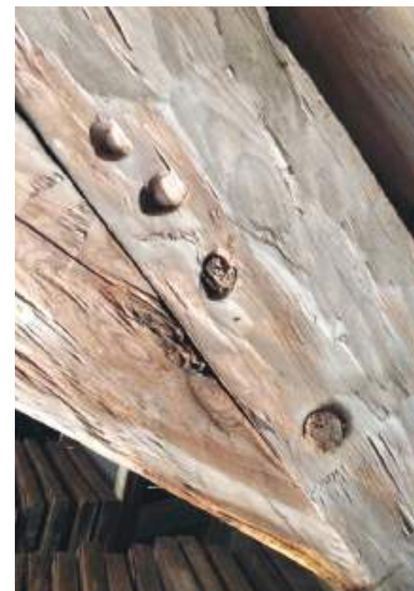
Pukissa porauksen alkukohta on pyöreämpi.
