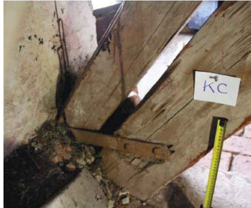
Muurista nousevat kattotuolin selkäpuu ja pukin jalka.
