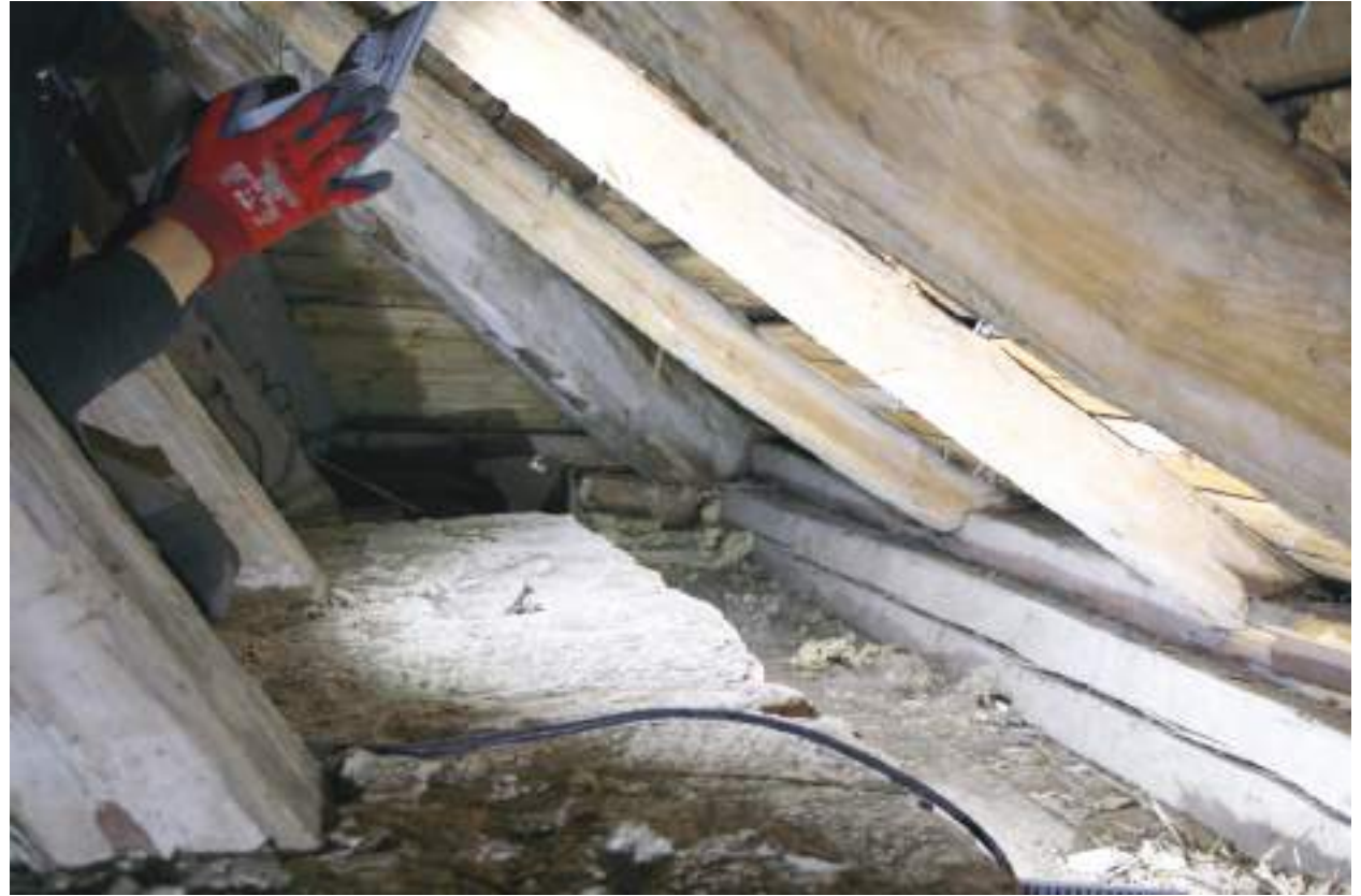
Osa jäleistä kaarevista hollantilaisista on korvattu kapeammalla puutavaralla. Luonnonväärit eli luonnollisesti kaareutuvasta puusta valmistetut hollantilaiset lepäävät massiivisen 7" x 7" räystääshirren päällä loveutuen koururäystääseen.
