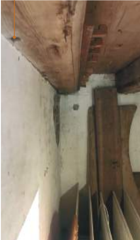
Porrashuoneeseen liittyvä varastotila avauksen alla. Seinän vieressä näkyy alapaarteen käpälän liitoksen tappi.
