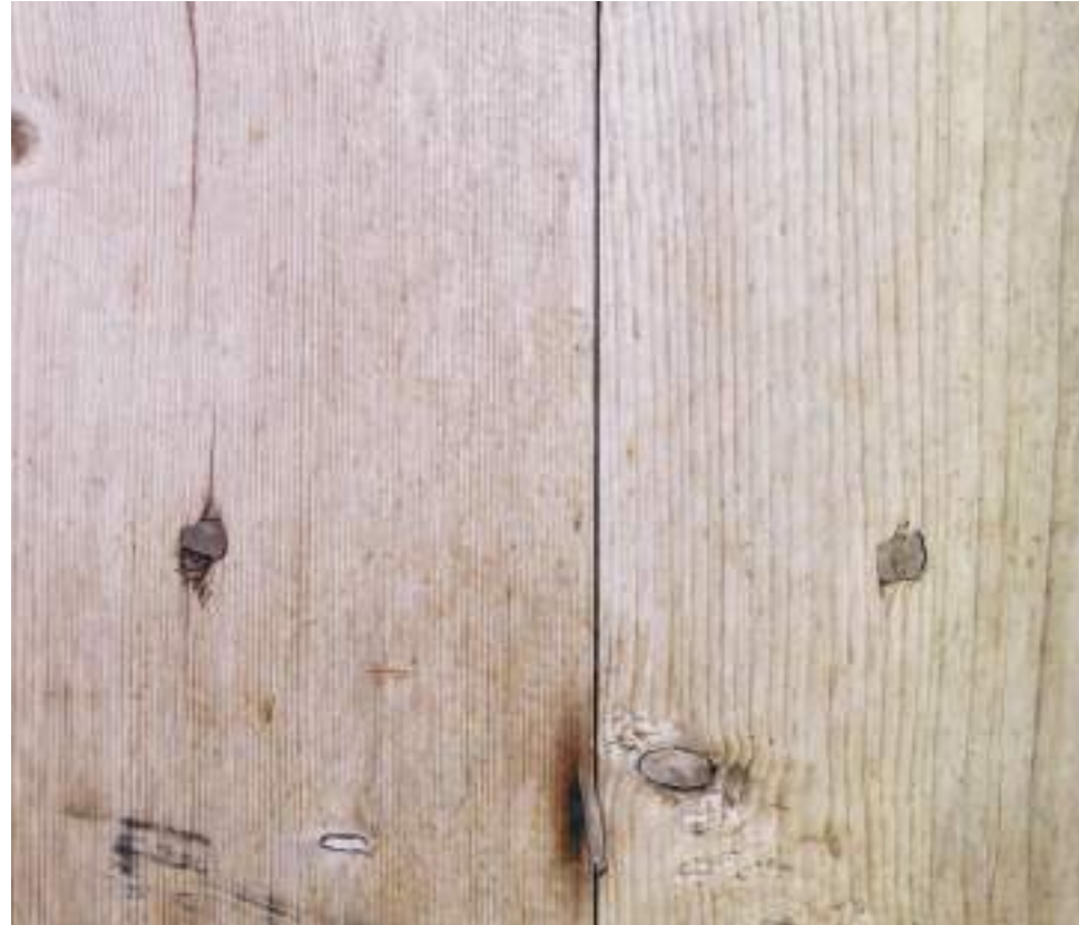
Laipiolaudoituksen listarakenteen liitoksen pieniä puunauloja.
