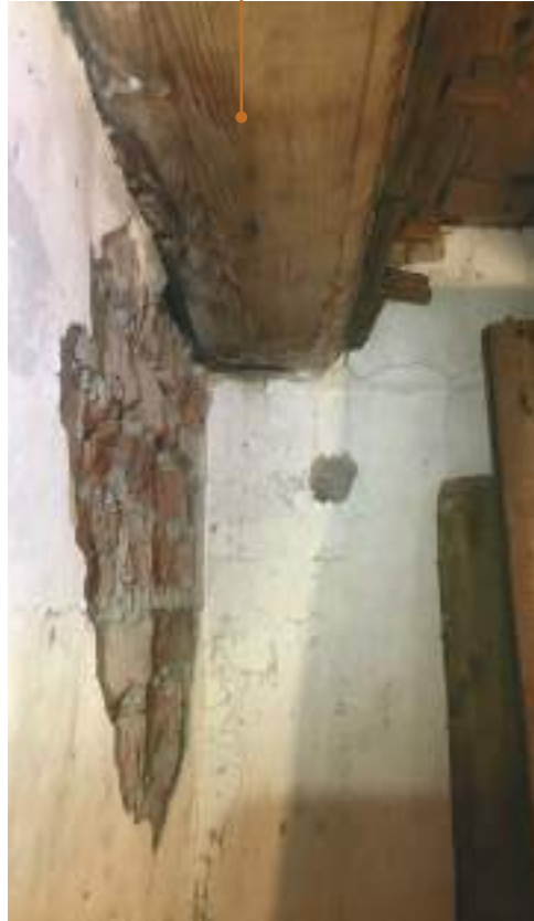
Rakennetta tutkittiin kosteusvaurioituneesta kohdasta, josta oli mahdollista kurkistaa muurin sisään.
