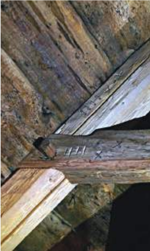
Vesikattorakenteen osat on nimikoitu.
