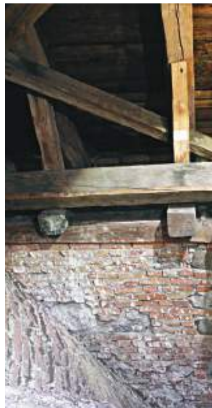
Kattotuolien käpälät lepävät jalasparrun päällä.
