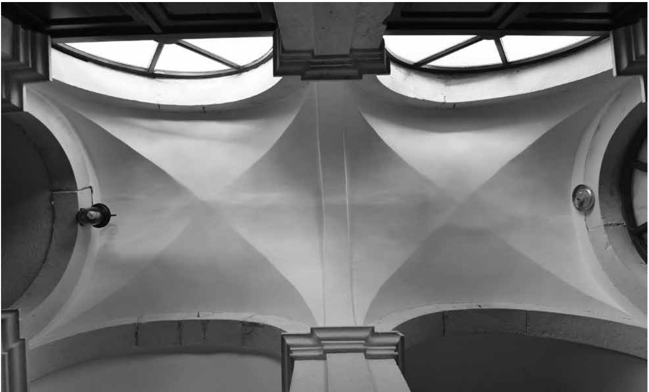
7. Križni svod podesta stubišta prvog kata »južne« palače Ivanišević u Makarskoj (foto: A. Vodanović) / Groin vault of the first floor staircase landing in the "south" palace of the Ivanišević family in Makarska (photo: A. Vodanović)
