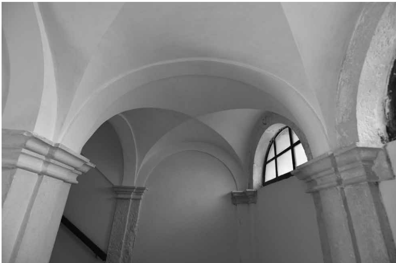
8. Svod međupodesta stubišta »južne« palače Ivanišević u Makarskoj (foto: A. Vodanović) / Vault of the intermediate staircase landing in the "south" palace of the Ivanišević family in Makarska (photo: A. Vodanović)
