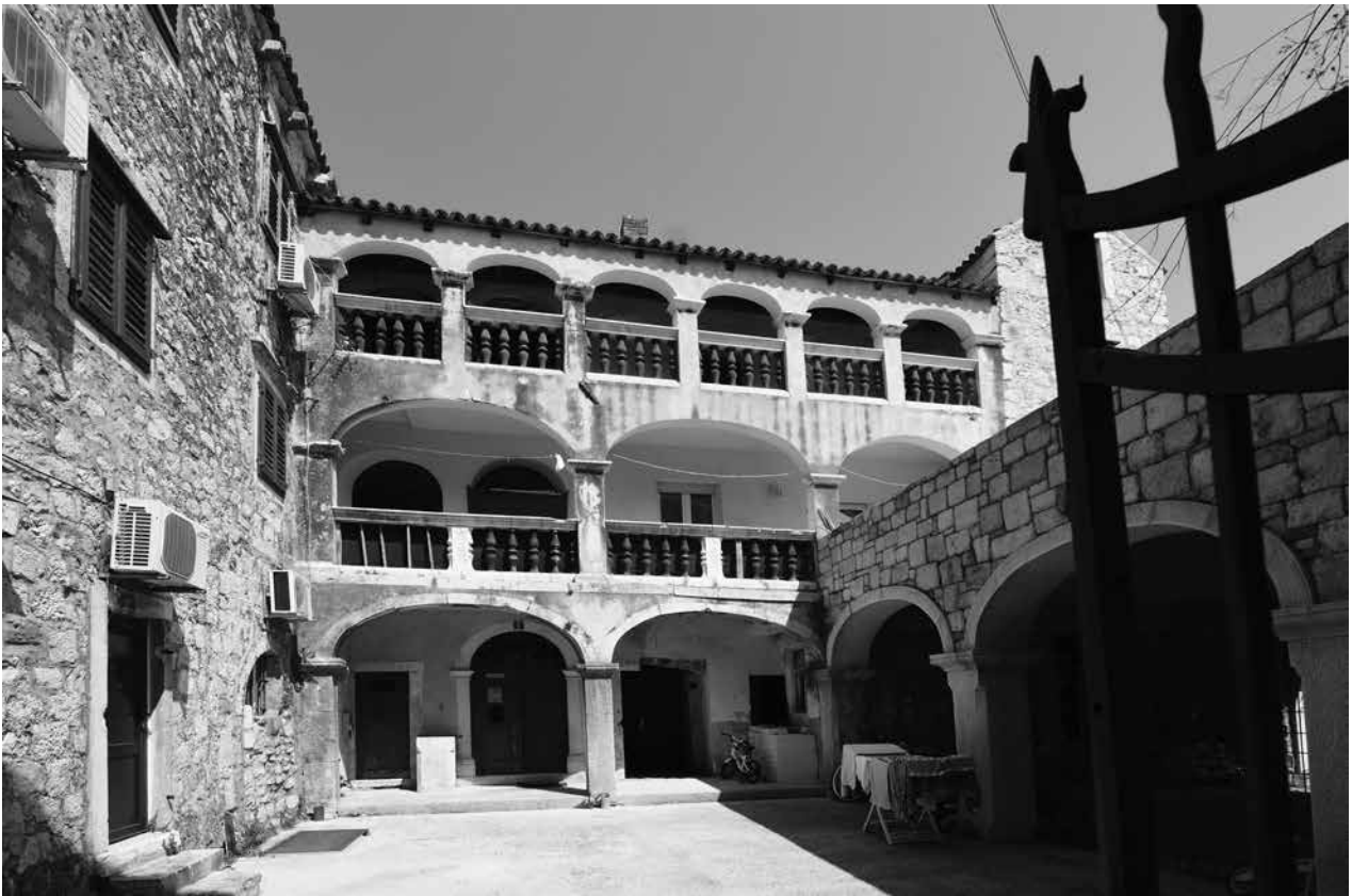
6. Pogled na sjeverno krilo »južne« palače Ivanišević u Makarskoj (foto: A. Vodanović) / View of the north wing of the "south" palace of the Ivanišević family in Makarska (photo: A. Vodanović)
