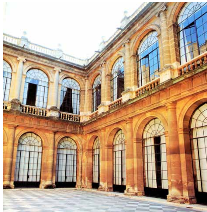
Casa de Contratación, edificio de Juan de Herrera
