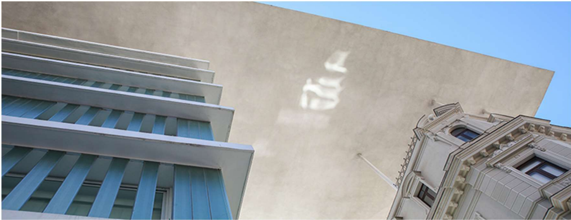
Figura 34- Vista dos prédios do Museu de Arte do Rio (M.A.R) com evidência para a estrutura que cobre os edifícios. Disponível em: http://www.museudeartedorio.org.br/pt-br/o-mar/arquitetura
