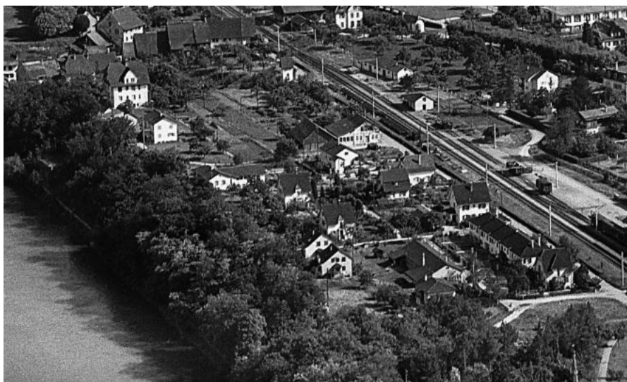
Abb. 30: Mittskirch 1953, Luftaufnahme von Nordwesten, W. Friedli, Ausschnitt. Oben links «Burg»-Quartier, davor das dreieinhalb-geschossige Haus Neff von 1914; unten rechts: Reihenhäuser erbaut 1930, dazwischen Bauten der 1920er–40er-Jahre.
