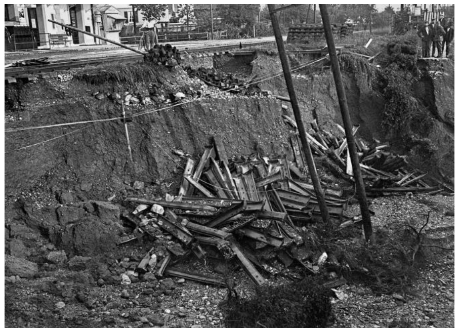
Abb. 7: Unterspülte Geleise im Bereich des Bahnhofs nach Überschwemmung des Zurzibaches 1931.
