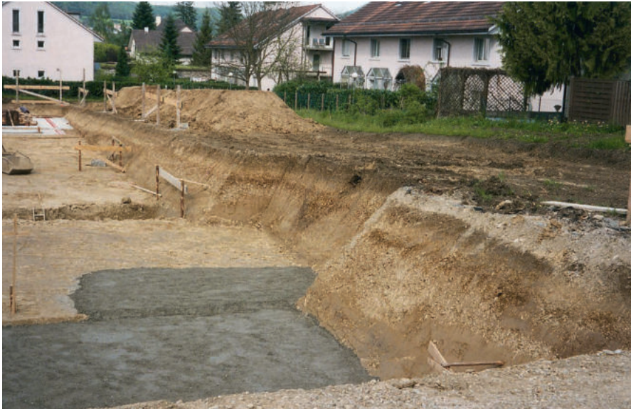
Abb. 4: Baugrube Schulhaus Neuberg 2001, von Süden gesehen. Die gelbe Schwemmschicht ist auf der ganzen Länge zu sehen. Darunter zeichnet sich ein Graben ab, der wahrscheinlich von einem alten Bachlauf stammt.
