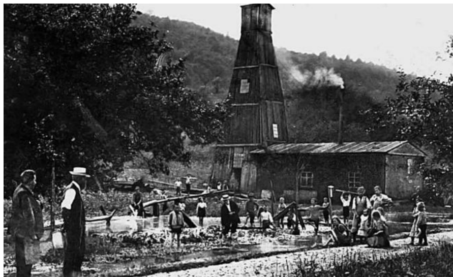
Abb. 34: Oberste Bohrstelle in den «Schulmatten», bei welcher 1914 die Bohrung auf Anordnung des Kantons durch das Salzlager hindurch bis in eine Tiefe von 416 m abgeteuft wurde, um nach Kali- oder Kohlevorkommen zu suchen. Statt auf Kohle stiess der Bohrmeissel auf eine Wasserader, und es schoss am 19. Juni 1914 heisses Wasser aus dem Bohrloch.
