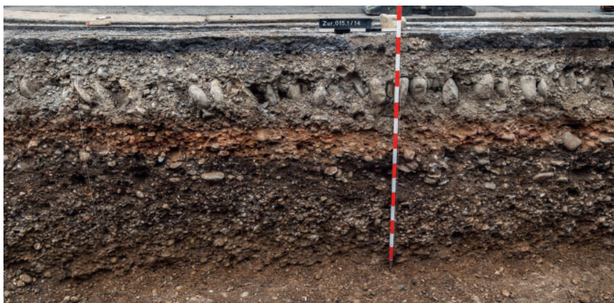
Abb. 7: Schwertgasse / Promenadenstrasse (Zur.015.1). Blick nach Süden auf das Leitungsgrabenprofil. Von unten nach oben: Der anstehende rotbraune Kies wird von der grauen kiesigen Planierungsschicht einer mutmasslichen römischen Strasse überlagert, darauf hat sich ein humushaltiger Nutzungs- bzw. Auflassungshorizont gebildet, darüber folgen ein jüngerer, mutmasslicher Strassenkörper aus rotem Kies und das Strassenpflaster des 18. Jh. mit Unterbau.
