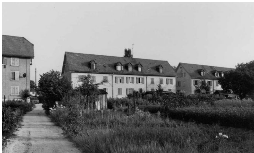
Abb. 43 a: Arbeiterwohnhäuser von der Gartenseite.
