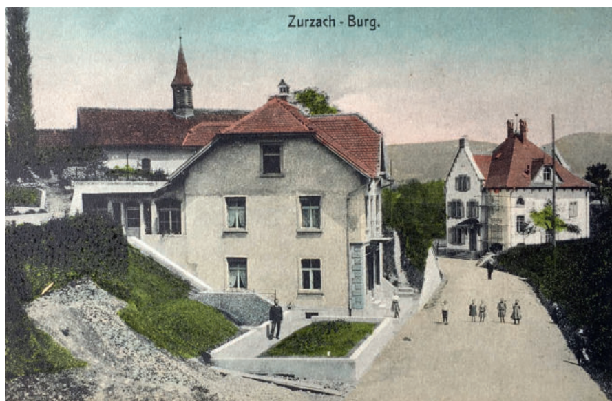
Abb. 23: Neue Landstrasse zur Rheinbrücke und nach Rekingen. Bäckermeister Adolf Rösch (Verenahof) liess 1909 an dieser neuen Verkehrsader ein Wohnhaus mit Laden errichten, wo sich deutsche Kundschaft (lt. Paul Bächle) sonntags mit frischen Brötchen eindecken konnte.
