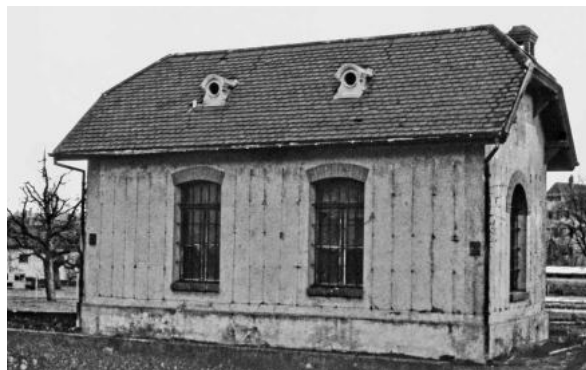
Abb. 20: Pumpstation der Zurzacher Wasserversorgung, erbaut 1901.
