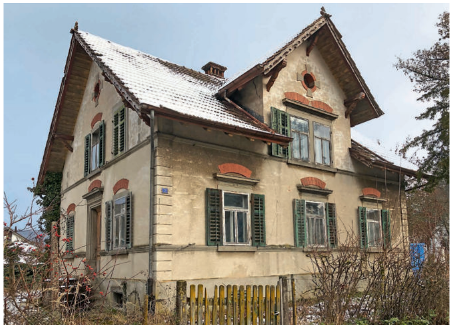
Abb. 18: «Mandscherei»- Haus in originalem Zustand, vor der Renovation 2022.
