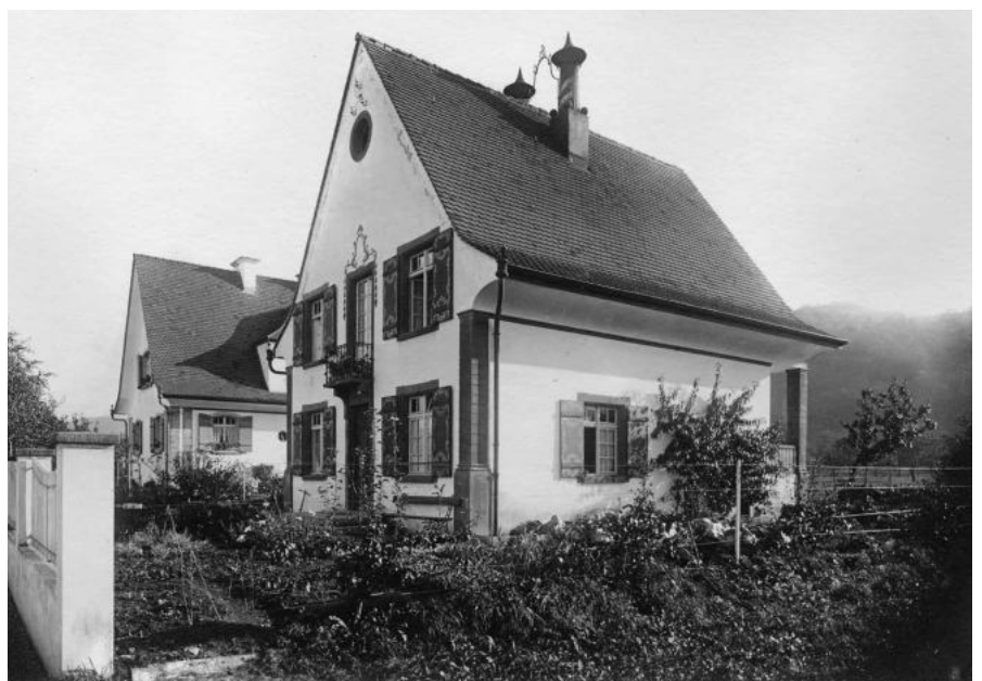
Abb. 21: Mallaun/Alexander von Senger Häuser an der Breitstrasse 6 und 8, von Nordwesten.
