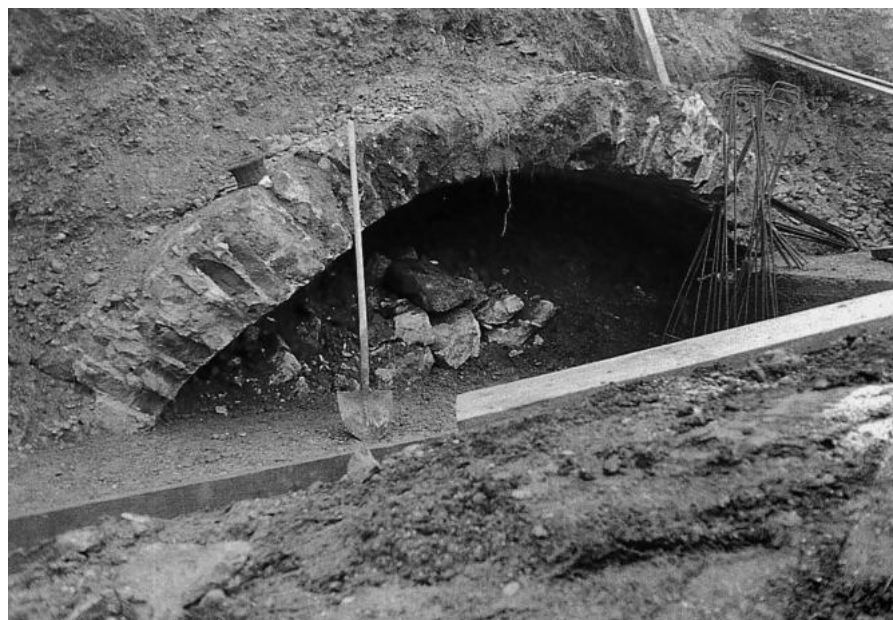
Abb. 15 b: Kellergewölbe, das beim Bau eines Luftschutzkellers zum Vorschein kam.
