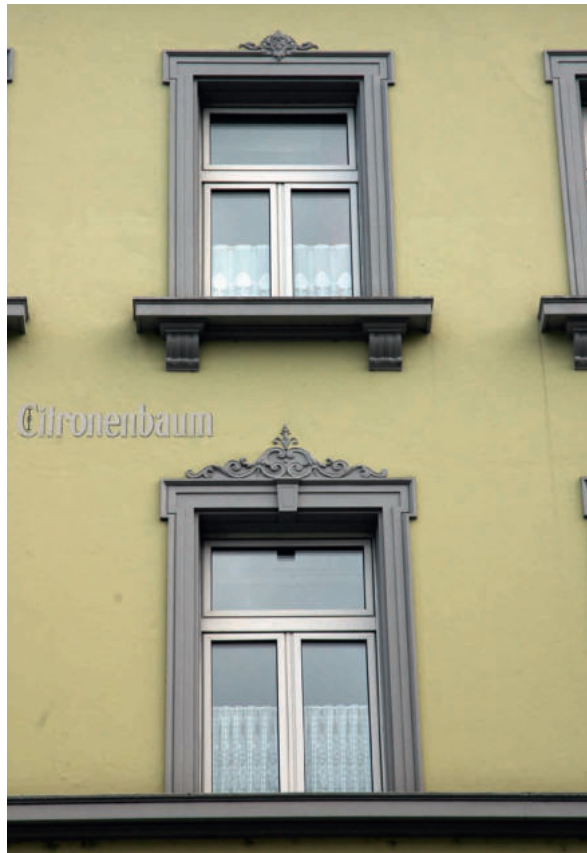
Abb. 11 a–d: Zuberbühlerbauten, Vorfabrizierte Zierelemente. b) Haus Zitronenbaum, 1888, Gliederungselemente c) Stuckdetail Kustorei mit Farbfassung aus der Bauzeit, 1890 d) Fenstergewände am Haus «Lange Bank» e) Gliederungsdetail Villa Himmelrich, 1900.
