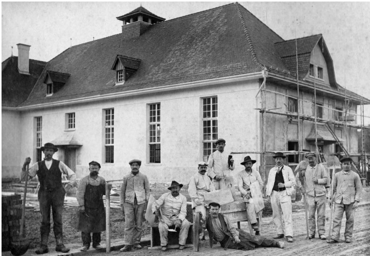
Abb. 19: Bau der Turnhalle, 1912. Mit ernster Miene präsentieren sich die am Bau beteiligten Handwerker mit ihren Werkzeugen und Geräten. Beim dritten Mann von rechts in dunklem Gilet handelt es sich um den Baumeister Elzi De Conto, der 1917 sein Baugeschäft an die Gebrüder Mallaun verkaufte.
