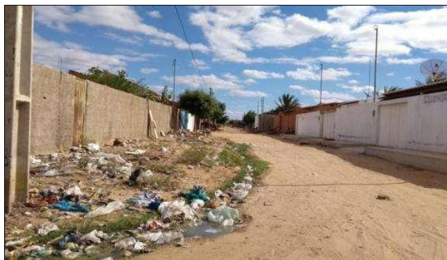
Figura 03: Rua sem pavimentação no bairro Dom Avelar, Petrolina – PE
