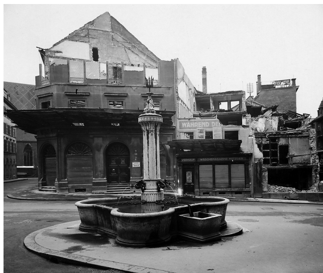
4 Abbruch von Häusern an der Freien Strasse um 1929/1930. Démolition de maisons à la Freie Strasse, vers 1929/1930. Demolizione di case nella Freie Strasse verso il 1929/1930.
