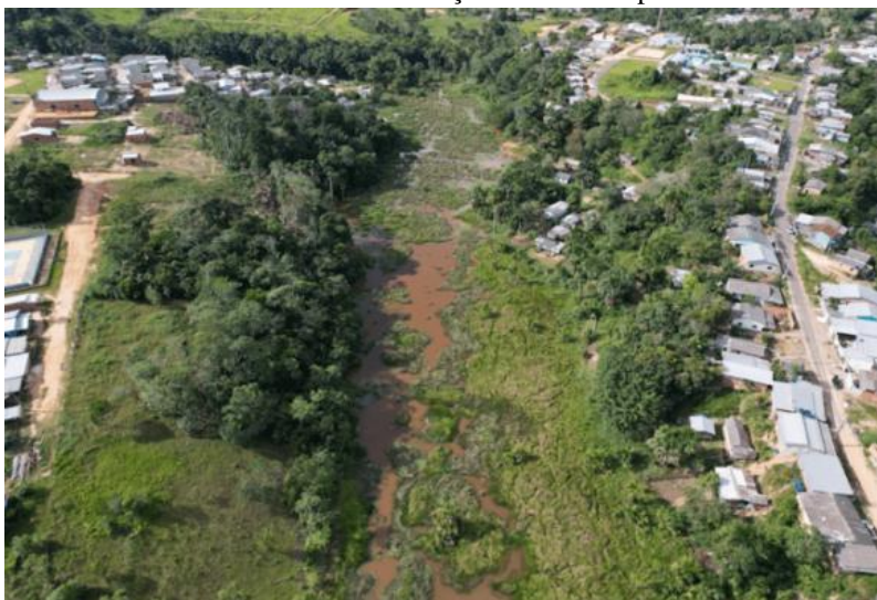
Figura 7. Foto aérea que mostra a construção de residências próximo ao Igarapé São Salvador. Observações in loco do ponto 02
