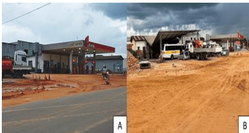
Figura 4. Imagem que mostra o posto de gasolina situado próximo ao Igarapé São Salvador.
