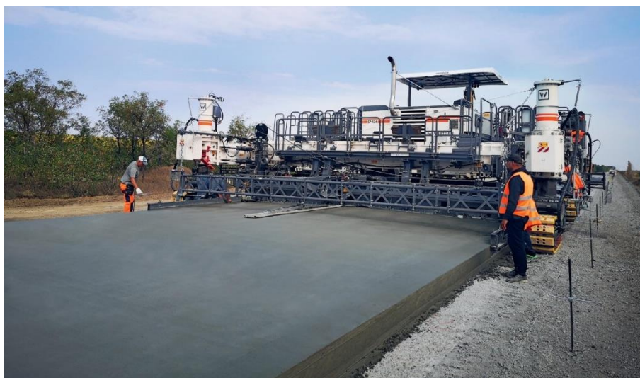
2-rasm. Sirpanuvchi qolipli betonyotqizgich yordamida sementbeton qorishmasini yotqizish
