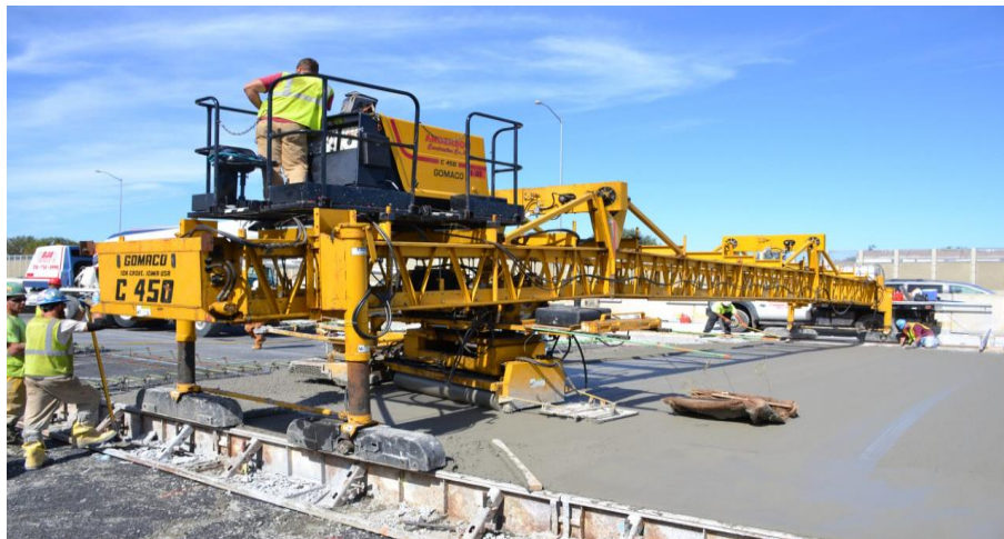
1-rasm. Rel’s qoliplar yordamida sementbeton qorishmasini yotqizish
