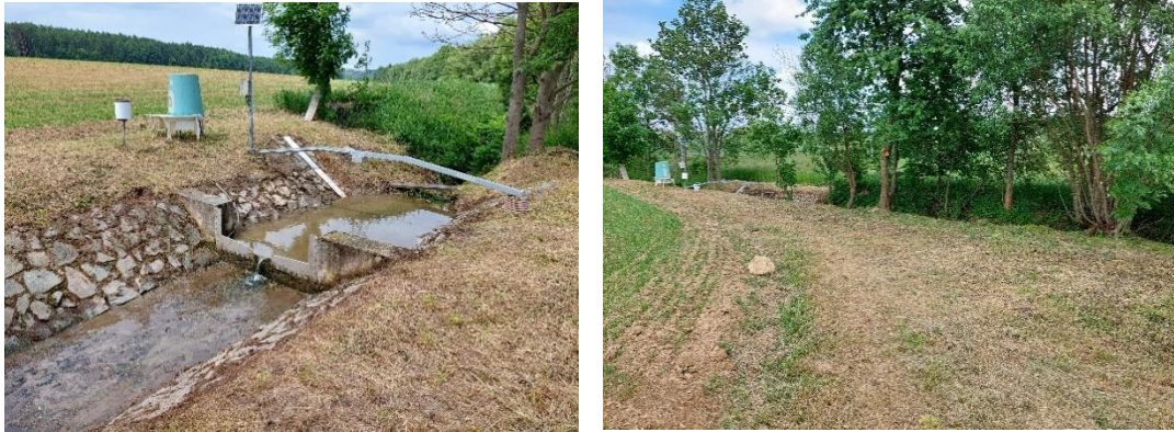
Obr. 14: Thomsonův měrný přeliv (vlevo) a poloha budoucího bioreaktoru (vpravo)
