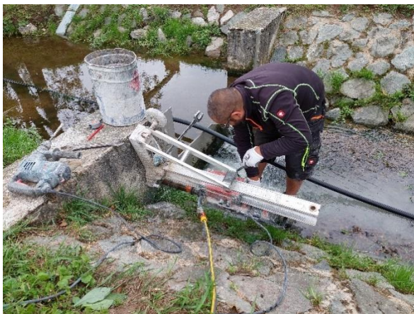
Obr. 16: Jádrové vrtání prostupu stávajícího měrného profilu pro vodovodní potrubí
