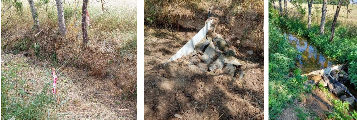
Obr. 15: Ukázka výstavby vzdouvací přehrážky v korytě toku
