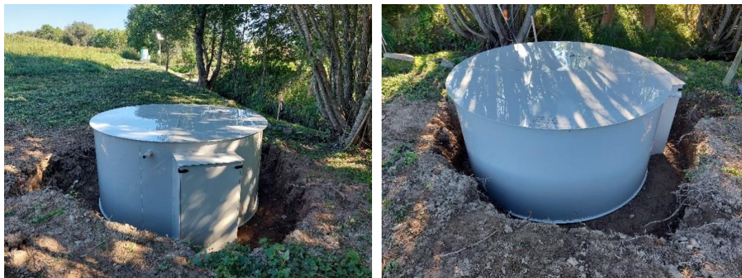
Obr. 18: Prvotní usazení bioreaktoru dne 6.9.2023
