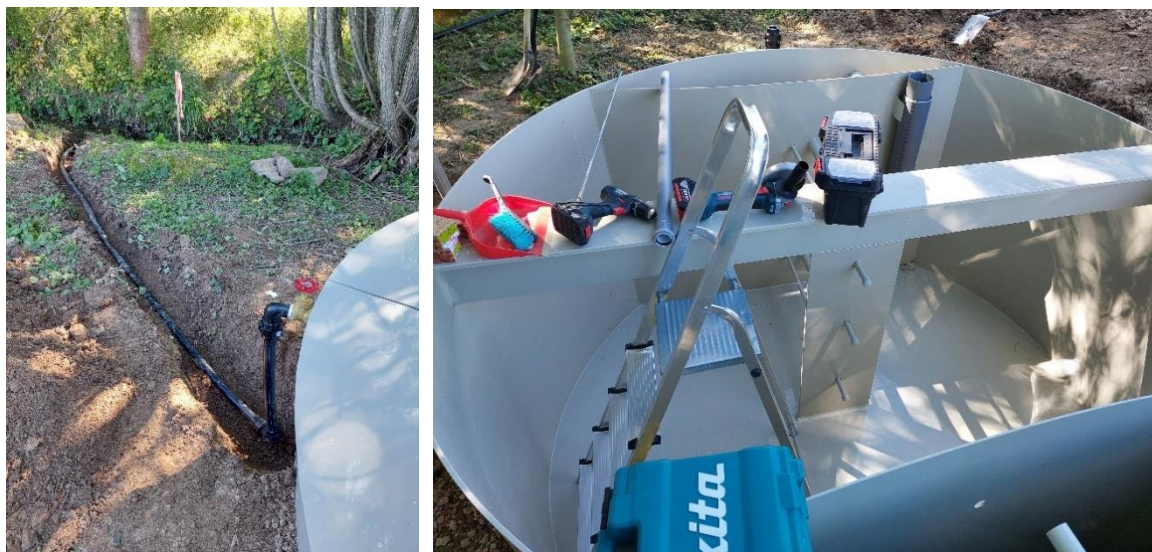
Obr. 19: Práce na konstrukci bioreaktoru (vlevo přívodní potrubí vody včetně škrťacího ventilu, vpravo úpravy vnitřních prvků bioreaktoru)
