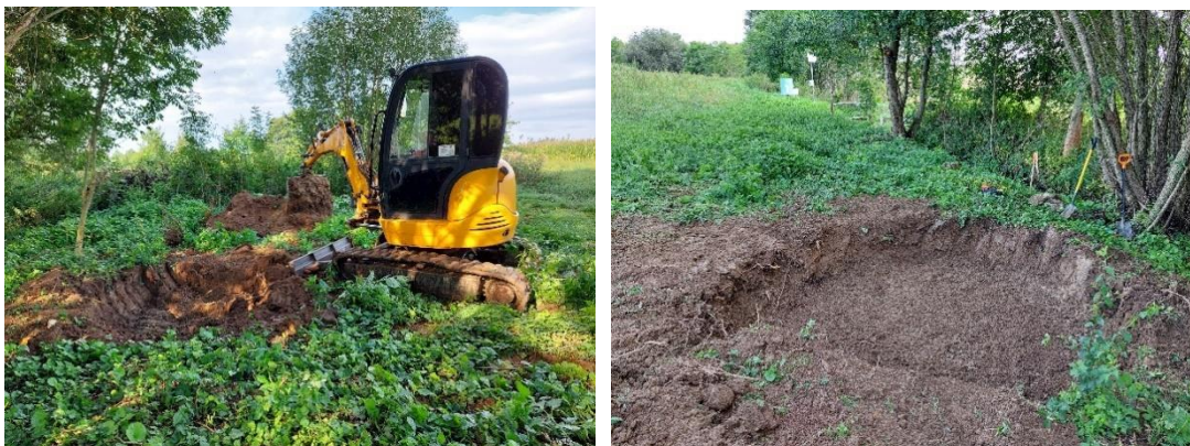
Obr. 17: Terénní práce při výkopu lokality pro budoucí usazení bioreaktoru dne 31.8.2023
