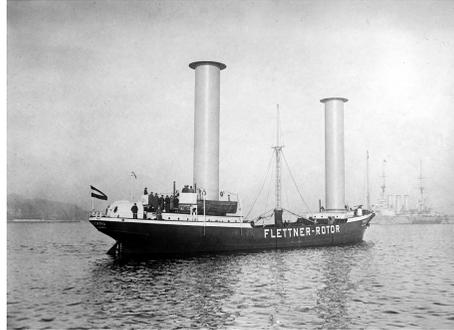
Figura 103. La nave a rotore Buckau.<sup>165</sup>
