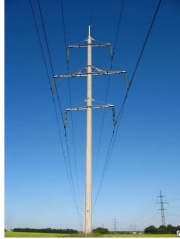
Şəkil 3. Dəmir-beton dayaq
