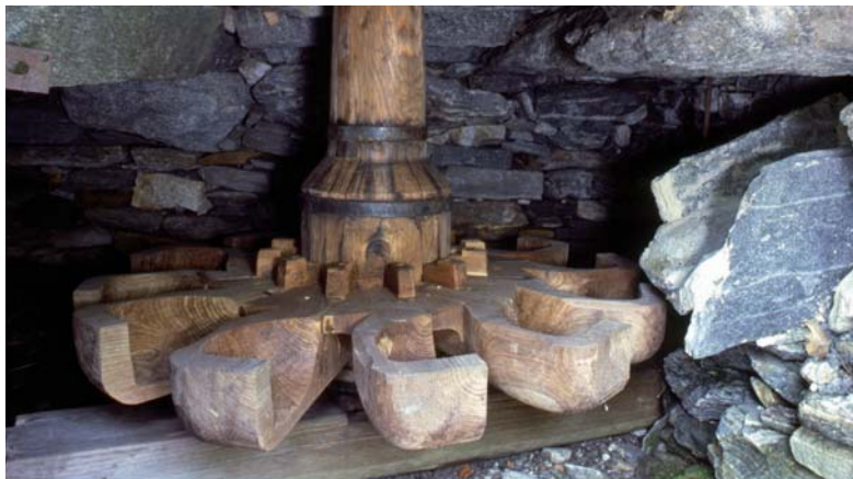
Ruota orizzontale del mulino Maddalena a Gordevio. (Fototeca CDE, DIA-1985/0207)
