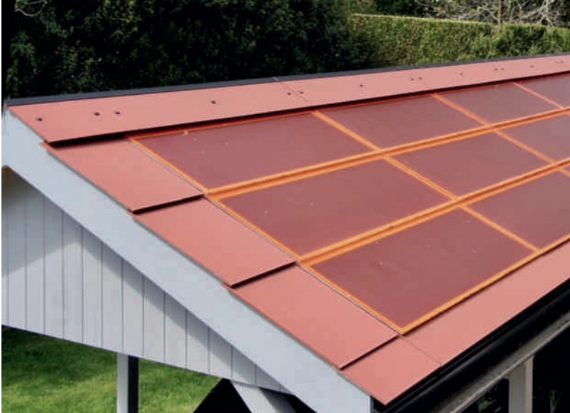
Die Photovoltaikdachseite mit der unsichtbaren Befestigung. Auf jeder Dachseite wurden die gleichen PV-Module und Faserzementplatten verwendet.
