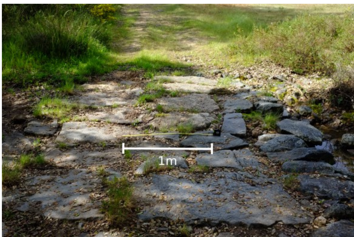
Figura 38: Calçetamento do vau de uma linha de água junto ao Monte do Almo (Azaruja)
