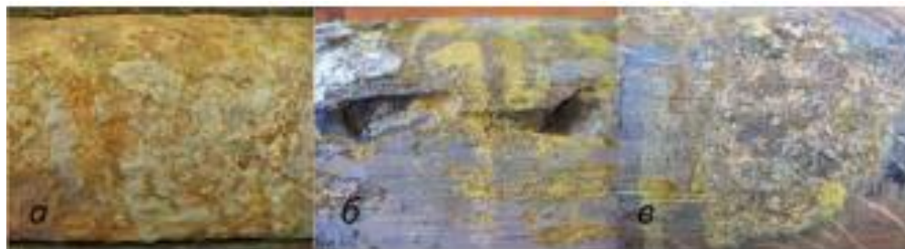
а) общая коррозия; б) питтинговая коррозия; в) коррозия пятнами
