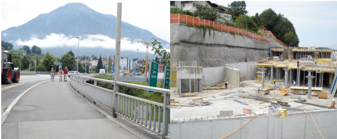
Abbildung 16: Autobahnquerung und Bären-Überbauung (aufgenommen durch Begehungsteilnehmende, 2009)
