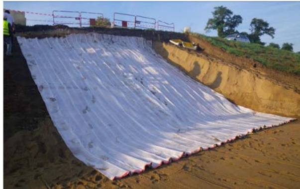
FIGURE 5. Site de Bou-la-Binette, 2014, détail du géocomposite de drainage - la partie visible (en blanc) est le filtre en contact avec la recharge. Les mini-drains du géosynthétique améliorent également le drainage (Crédit photo DREAL Centre Val de Loire / DETL).
