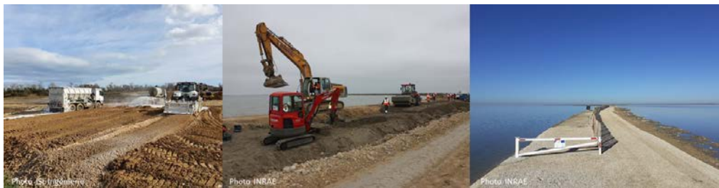
FIGURE 1. Vues de la construction de la plateforme : traitement, compactage, plateforme achevée.
