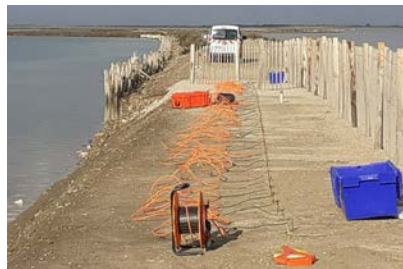
FIGURE 6. Mesures de Tomographie de Résistivité Électrique sur la plateforme.
