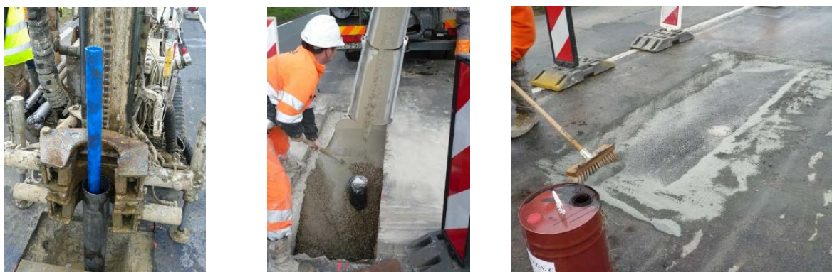
FIGURE 2. Mise en place d'un tubage d'essai de perméabilité pour le suivi à 10 ans d'une tranchée de sol mixe (source : DREAL CVL/DETL).
