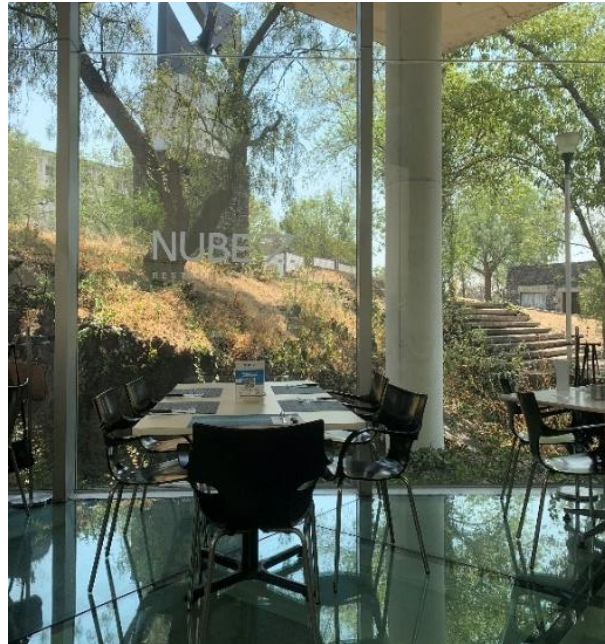
Figura 5. Canceles y piso de cristal del restaurante del MUAC, permitiendo la vista del entorno rocoso sobre el que se desplanta.
