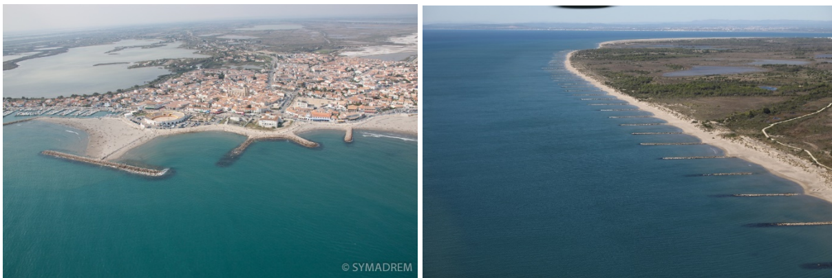
FIGURE 3. Ouvrages en enrochements sur le littoral de Camargue (photo de droite : © DREAL Occitanie).
