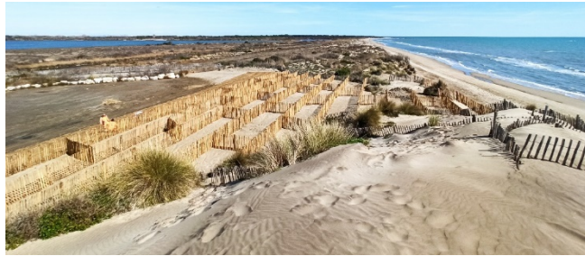
FIGURE 8. Photo post-travaux du renforcement du cordon dunaire des Baronnets.
