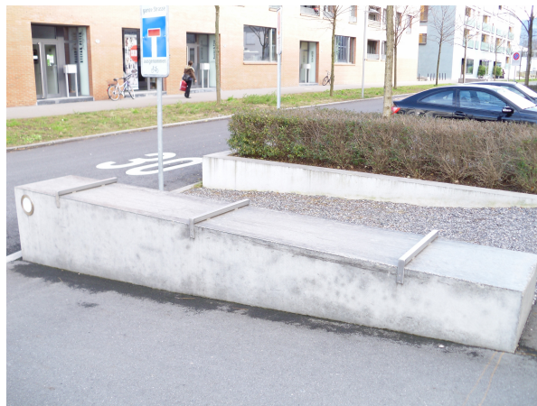
Abbildung 9: Skate-Stopper an den „Suva-Curbs“ in der Tribtschenstadt, Luzern (Foto vom Verfasser)
