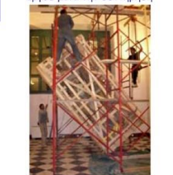
Εικόνα: Μεταφορά του έργου στην οριστική του θέση
