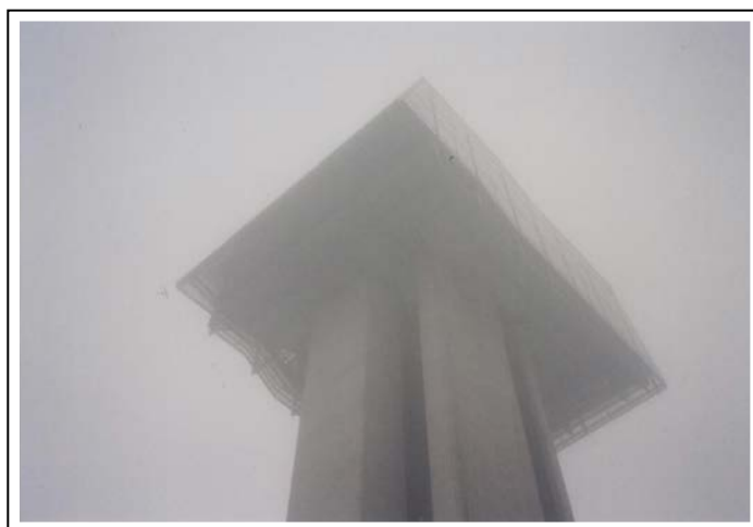
Figure 9 : Photo de la partie supérieure de la tour panoramique de la Gileppe
