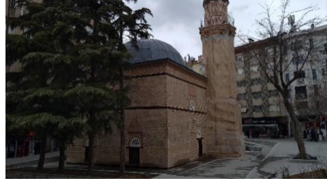
Şekil 13. Hoca Hasan Mescidi Güneydoğu cephesi (Kemerci, 2023)
