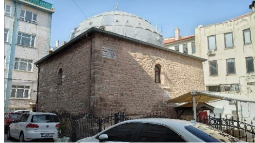
Şekil 22. Abdülmümin Cami Doğu cephesi günümüz (Kemerçi, 2023)
