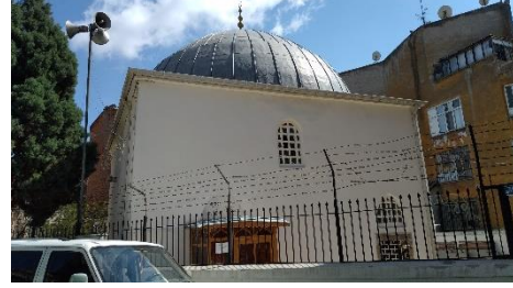
Şekil 20. Abdülaziz Cami Kuzey Cephesi günümüz (Kemerçi, 2023)
