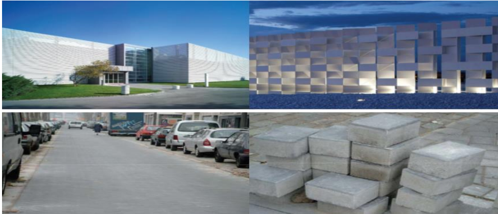
Şekil 1. Dış cephede kullanılan fotokatalitik seramik yüzey (URL-1); Leien caddesindeki fotokatalitik kaldırım blokları (Beeldens, 2006).
