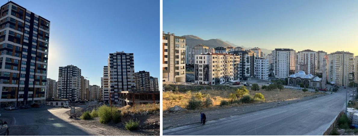
Şekil 13. Talas Mevlana Mahallesi, yaya yolu eksikliği, 2023, Halil İŞİK Arşivi
