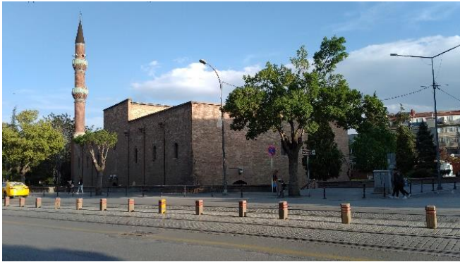
Şekil 41. İplikçi Cami Kuzeybatı cephesi günümüz (Kemerçi, 2023)
