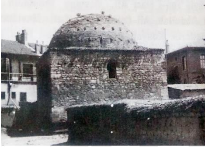
Şekil 22. Abdülmümin Cami Doğu Cephesi eski durumu (Konyalı, 1997)
