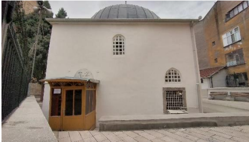
Şekil 17. Abdülaziz Cami Batı Cephesi (Kemerçi, 2023)
