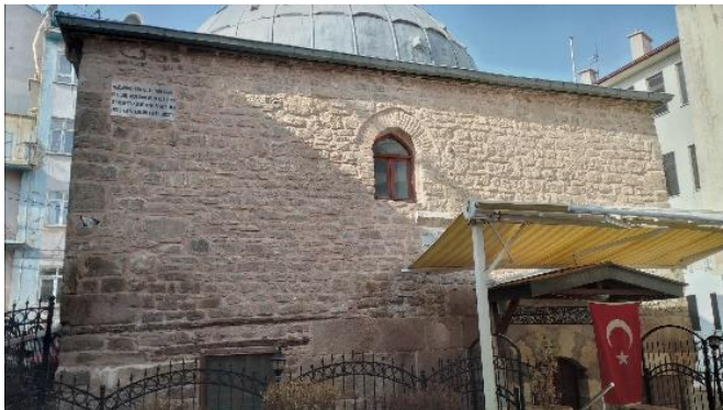
Şekil 20. Abdülmümin Cami Doğu Cephesi günümüz (Kemerçi, 2023)
