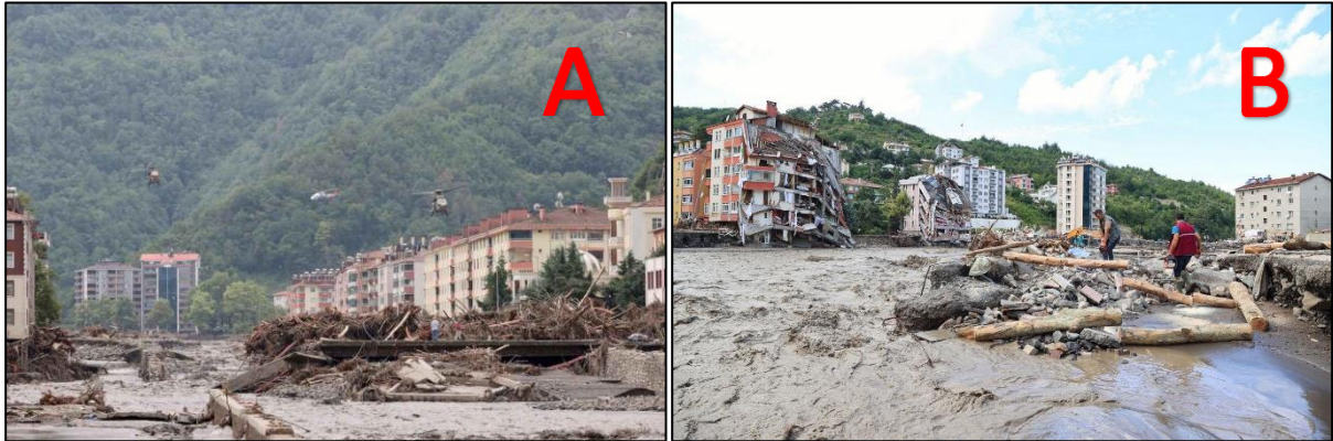
Şekil 1: Kastamonu ve Rize' de meydana gelen taşkınlar A) Rusubatın köprü, büz, menfez vb. yapıları tıkaması B) Taşkınla gelen malzeme (URL-1 ve URL-2)
