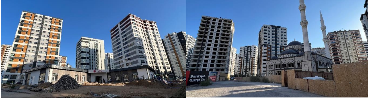
Şekil 13. Talas Mevlana Mahallesi, sağlık ocağı ve cami örneği, 2023, Halil IŞIK Arşivi
