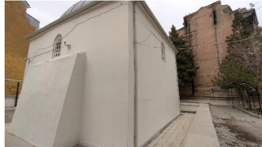
Şekil 18. Abdülaziz Cami Güneydoğu Cephesi (Kemerçi, 2023)
