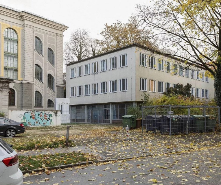
Der Abriss der Alten Stadtbücherei war beschlossene Sache, doch viele Bauteile ließen sich wiederverwenden (Bild: Stephan Bovenschen)
