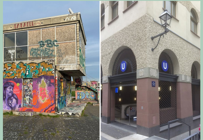
links: Berlin, Plattenvereinigung auf dem Tempelhofer Feld, Zukunftsgeräusche, 2011: Rezykliert wurden Betonplatten vom Münchner Olympiadorf und einer Wohnsiedlung in Frankfurt/Oder; rechts: Frankfurt am Main, Großer Rebstock/Markt 8, Jordi & Keller, 2013–2017: Die Waschbeton-Fragmente des Technischen Rathauses korrespondieren mit dem Rauputz über den Arkaden (Bilder: Hans-Rudolf Meier)
