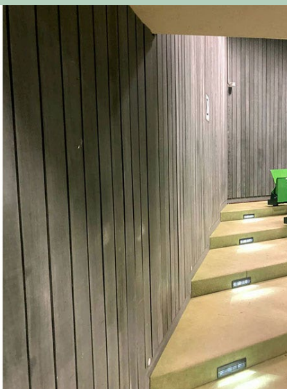
links: Waschtisch aus Marmor incl. zwei Waschbecken, 193 x 200 x 600 cm, aus einem Bürogebäude in Frankfurt am Main; rechts: Wandverkleidung aus einem Hörsaal der TU Dortmund, Nussbaumholz, 1.860 cm Gesamtbreite, 94 Bretter auf Lager (Bilder: Concular)
