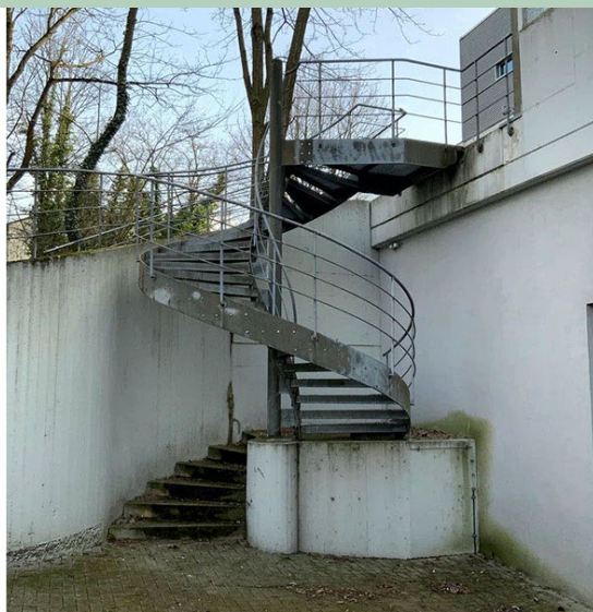
links: Wandleuchte dreieckig, 12 x 28 x 190 cm aus dem Landratsamt Karlsruhe; rechts: Gitterrosttreppe aus dem Fraunhofer ISE Frankfurt, verzinktes Stahl, 462 x 168 cm, ein Stück vorhanden (Bilder: Concular)
