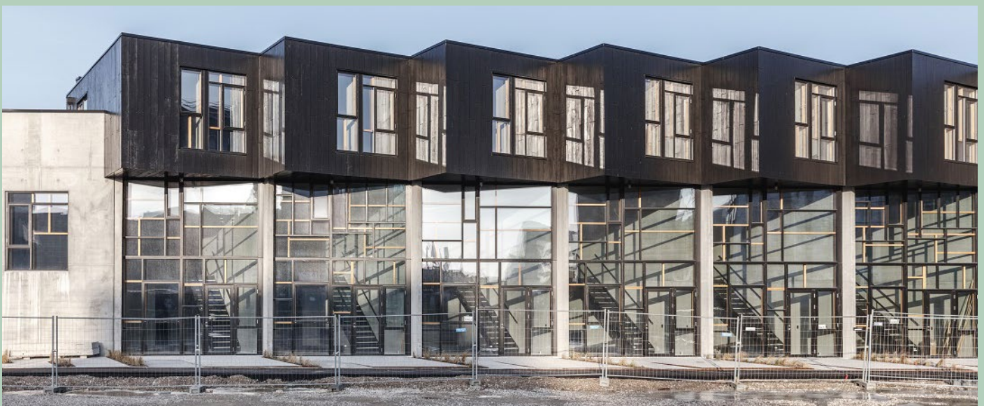
Kopenhagen Ørestad, Upcycle Studios, Lendager Group, 2015–2018: Die Fenster stammen von Abbruchliegenschaften in Jütland, der Beton vom U-Bahnbau in Kopenhagen (Bild: Lendager Group, Rasmus Hjortshøj)
