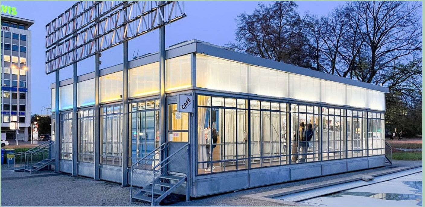
Berlin, BHROX bauhaus reuse-Pavillon auf dem Ernst Reuter-Platz, Zukunftsgeräusche, 2019: Recyclingbau aus den Fenstern der DDR-Sanierung des Bauhaus-Gebäudes in Dessau (Bild: Hans-Rudolf Meier)
