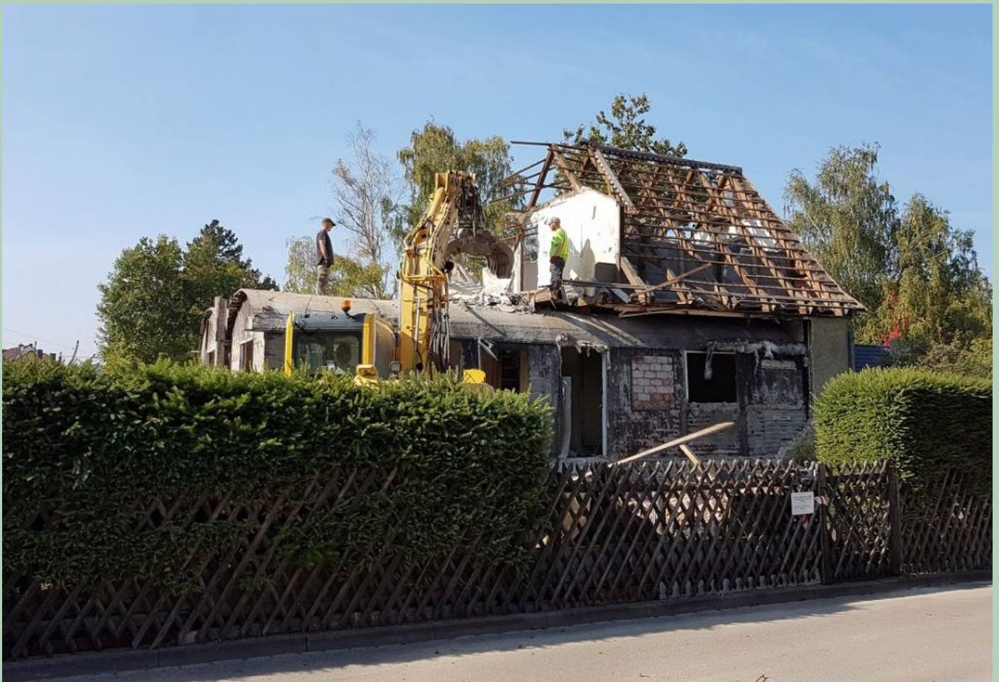
Feucht, Wohnhaus während des Abrisses (Bild: Herbert Bauer)
