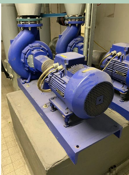
links: Treppengeländer aus der TU Dortmund, Metall/Stahl/Glas, Gesamtlänge 13.600 cm, 136 laufende Meter verfügbar; rechts: Kreiselpumpe KSB Etanorm 150-125-250 G11, aus dem Landratsamt Karlsruhe (Bilder: Concular)
