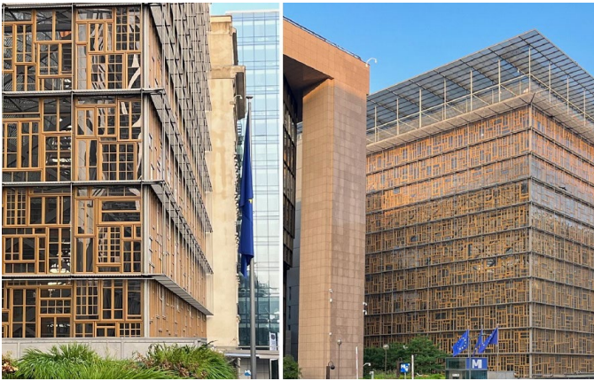
Brüssel, Europagebäude, Philippe Samyn and Partners, 2016: 3000 wiederverwendete Holzrahmenfenster sollen die Einheit in der Vielfalt der Europäischen Union versinnbildlichen (Bilder: Hans-Rudolf Meier)
