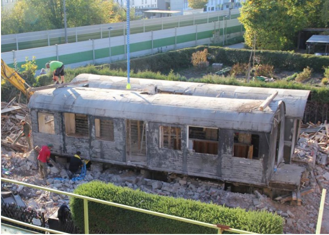
Feucht, Wohnhaus vor dem Abriss (Bild: Steffen Engel)
