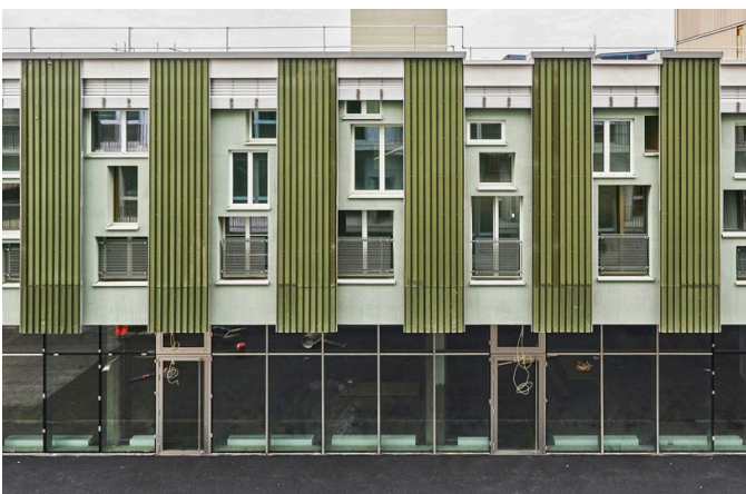
Basel, Kultur- und Gewerbehaus ELYS, Baubüro in situ, 2016–2020: Die Fenster stammen aus verschiedenen Lagerbeständen, die Abdeckbleche vom früheren Dach des Bestandsbaus (Bild: Martin Zeller)
