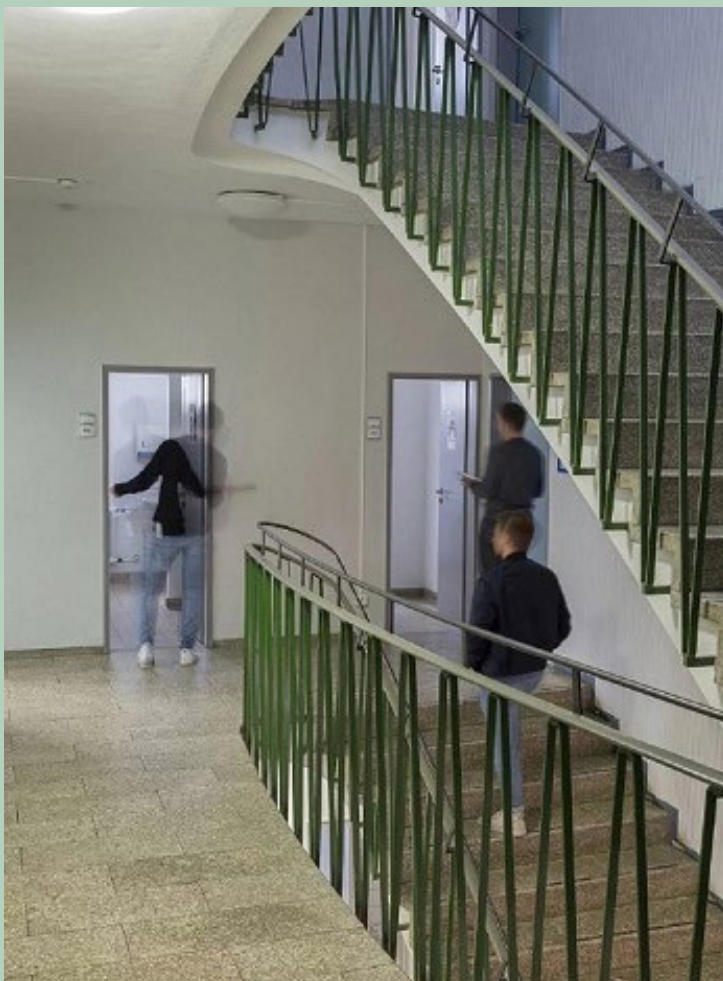
Alte Stadtbücherei in Augsburg, wiederverwendbare Bauteile werden ausgebaut (Bild: Stephan Bovenschen)
