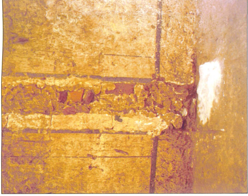
FIG. 10. — Empreinte d'un pilier de bois entre enduit. On distingue le colmatage de la fondation avec des fragments de tuiles.
