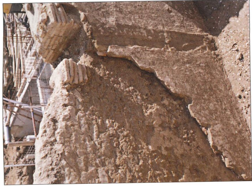
FIG. 13. — Vue de la contre-cloison sanitaire contre le mur M6. On aperçoit le conduit de briques du canal de chauffe ultérieurement prévu après remblaiement de la salle, pour alimenter en air chaud l'hypocauste inachevé.
