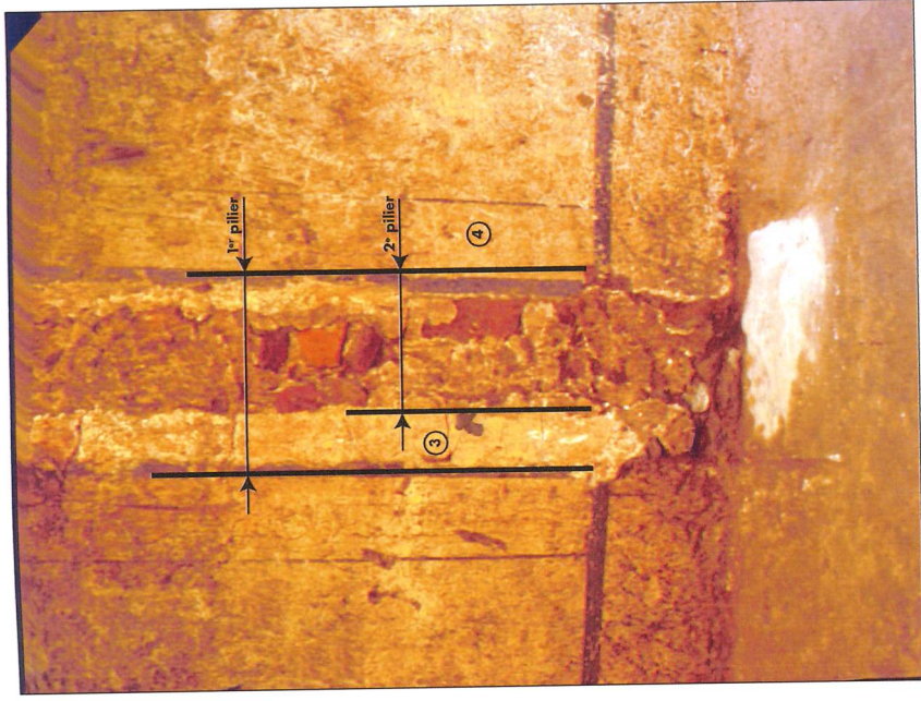
Premier pilier : larg. 0,33 m Deuxième pilier : larg. 0,17 m. 3 : Raccord de mortier colmatant la première empreinte 4 : Fournitures de fragments de briques au niveau du massif de fondation.
