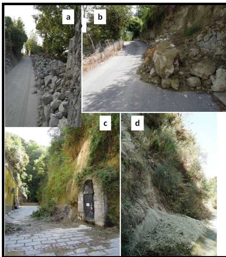
Foto 3: Fenomeni di collasso di muretti a secco a Casamicciola in via dei Carri (a), e in via Nizzola (b); piccole frane nei depositi vulcanoclastici in via Nizzola (c) e in via S. Barbara (d).
