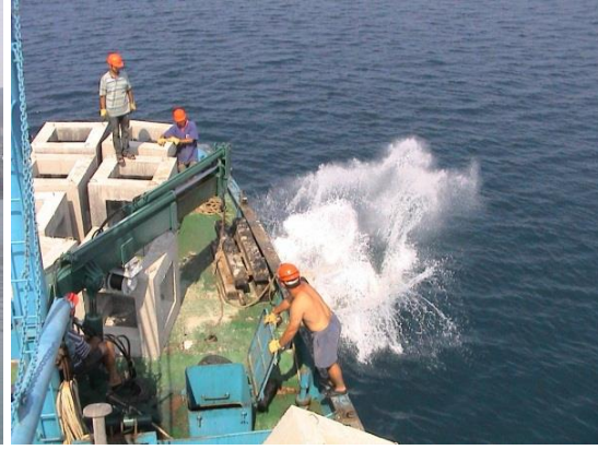
Şekil 3. Yapay resif bloklarının taşınması ve suya bırakılması
