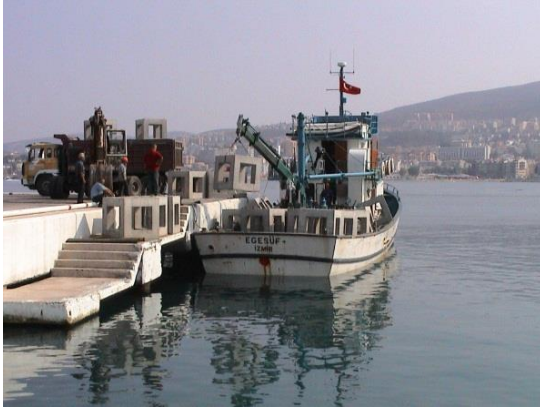
Şekil 3. Yapay resif bloklarının taşınması ve suya bırakılması
