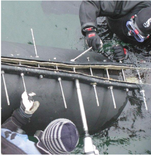
Şəkil 1. Mühafizə köynəyinin quraşdırılması.
