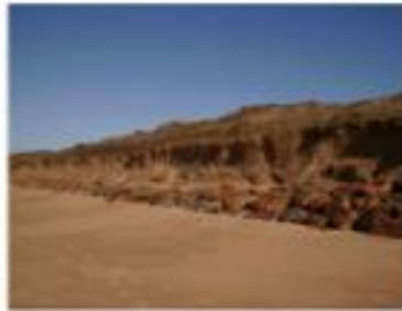
Les dunes ont reculé de plusieurs mètres en arrière des attachements de la construction.
