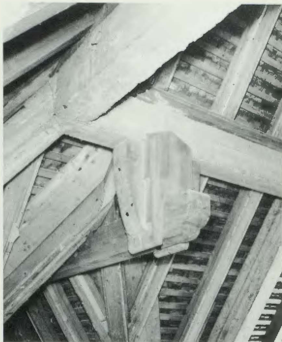
Verbindungsstelle im Dachstuhl zwischen Beton-Tragrahmen und Holzgebälk
