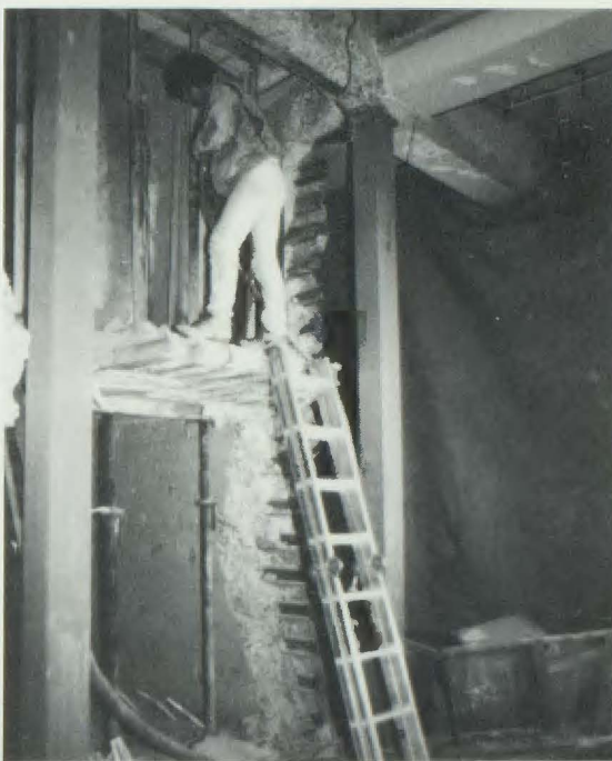
Vorbereitungsarbeiten zur Sprengung einer Tresoranlage im Erdgeschoss während des Umbaus
