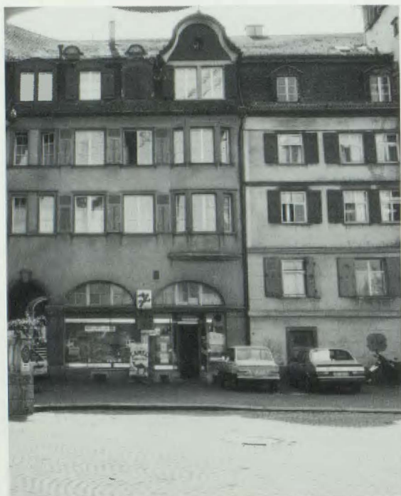
Ostfassade Richtung Obstmarkt im Vorzustand und nach dem Umbau
