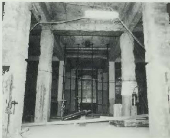
Freigelegter Bereich der Skelett-Konstruktion im Erdgeschoss
