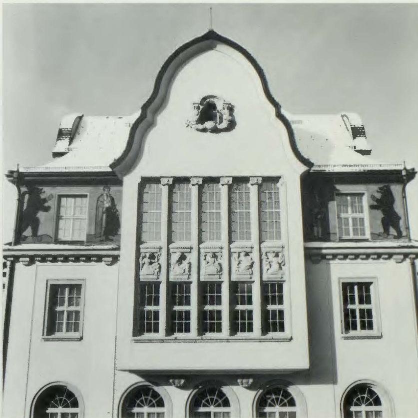
Ostfassade mit Wandbildern und Steinmetzarbeiten
