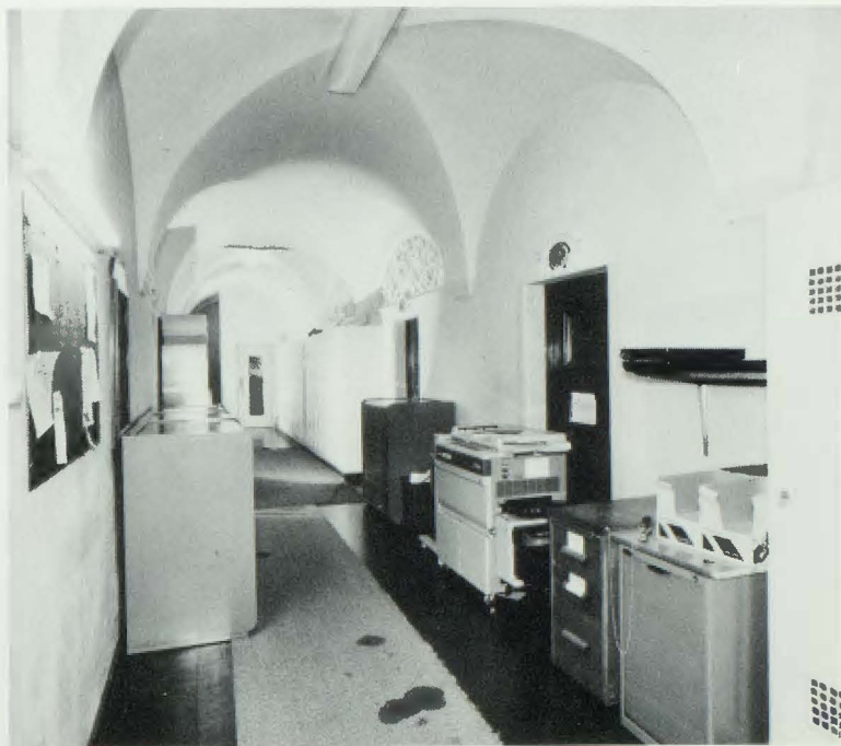
Korridor im 1. Obergeschoss des Hauptgebäudes vor dem Umbau . . .
