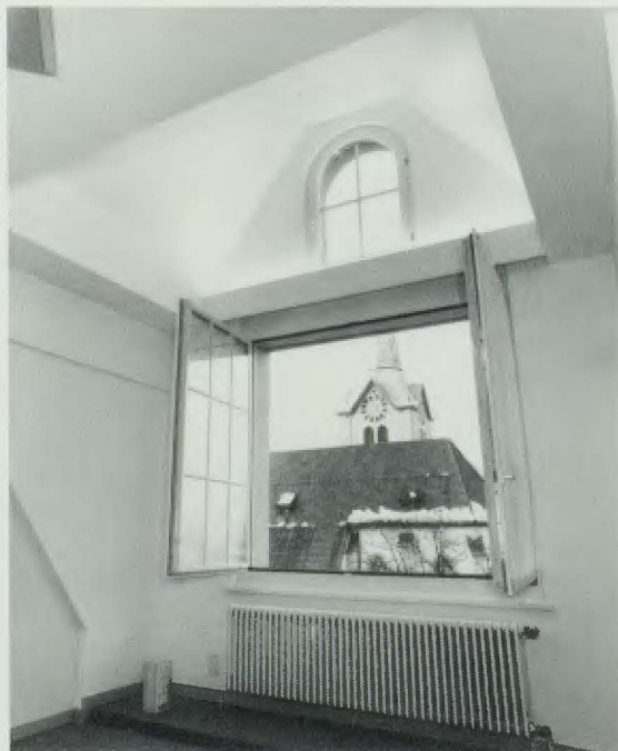
Lukarnenbereich des Konferenzsaals nach der Fertigstellung
