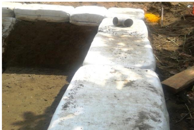
Gambar 4. Keduk Teplok dan penyusunan Cetakan
