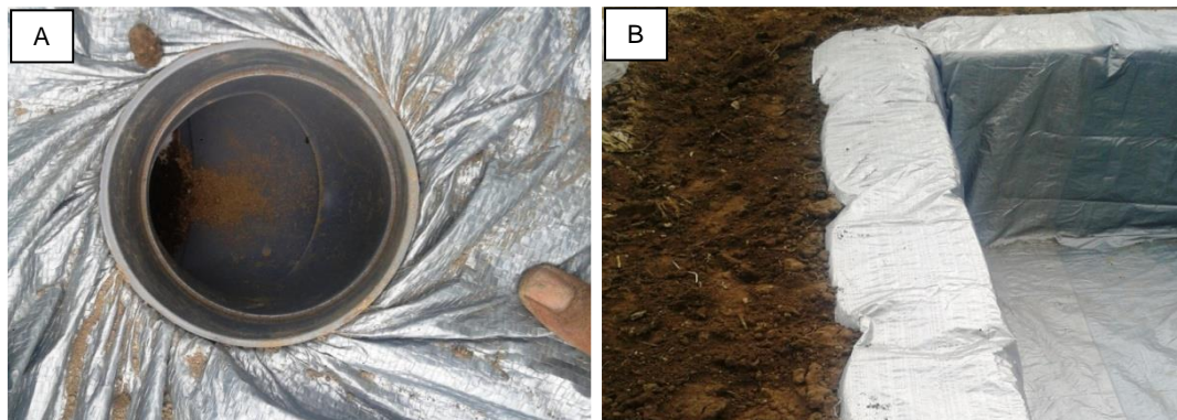
Gambar 5. A) Pembuatan Outlet, B) Pemasangan terpal
