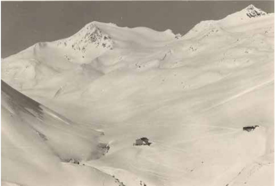
Abb. 42: Die alte und die neue Samoarahütte (heutige Benennung der neuen Samoarahütte: Martin-Busch-Hütte)
