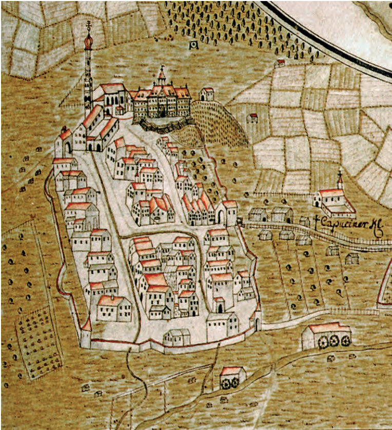
Undatierte Ansicht von Bludenz aus dem 18. Jahrhundert, die den Verlauf der Wassergräben in den Gassen der Stadt sowie deren Abflüsse, nicht aber die Zuleitung der Armatin zeigt (Stadtmuseum Bludenz)
